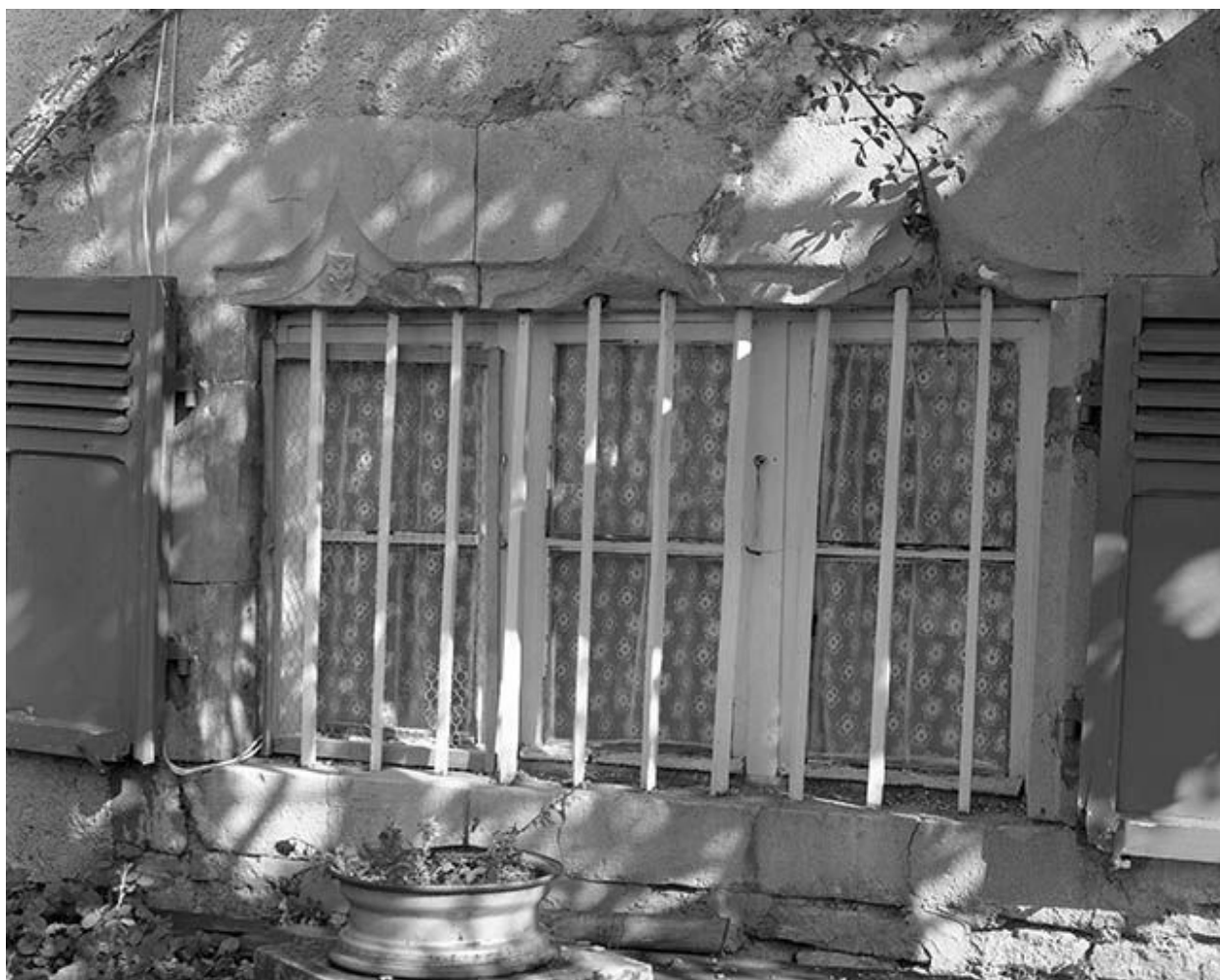
Façade postérieure : baie du rez-de-chaussée.
