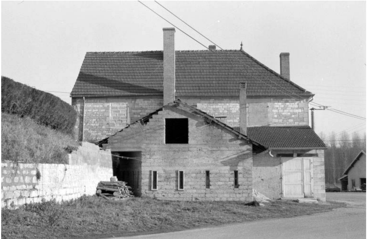
Chambre à lait, depuis l'ouest.
