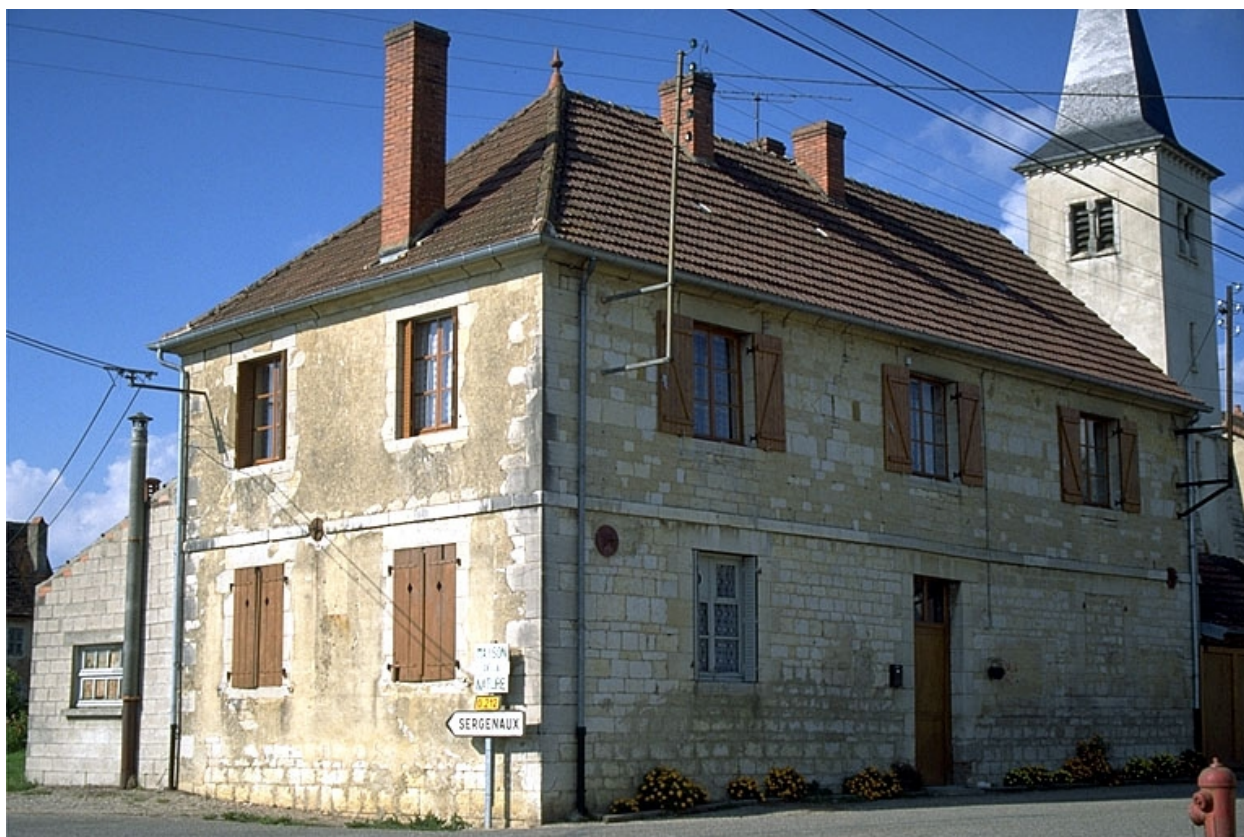
Ancienne école, vue de trois quarts gauche.
