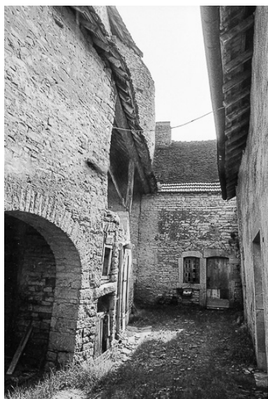
Petit logement au fond de la cour. Phot. Bernard Lardière IVR43_19817000320Z
