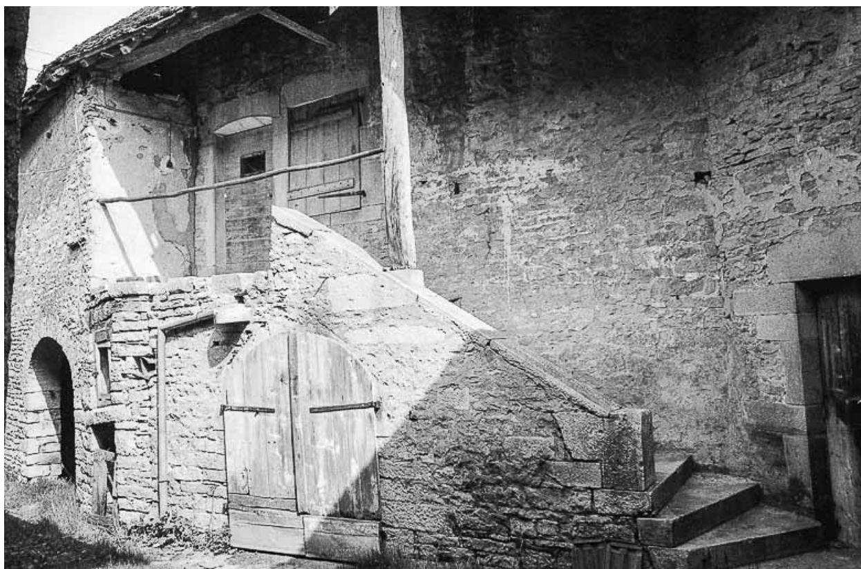
L'habitation, à gauche dans la cour.
