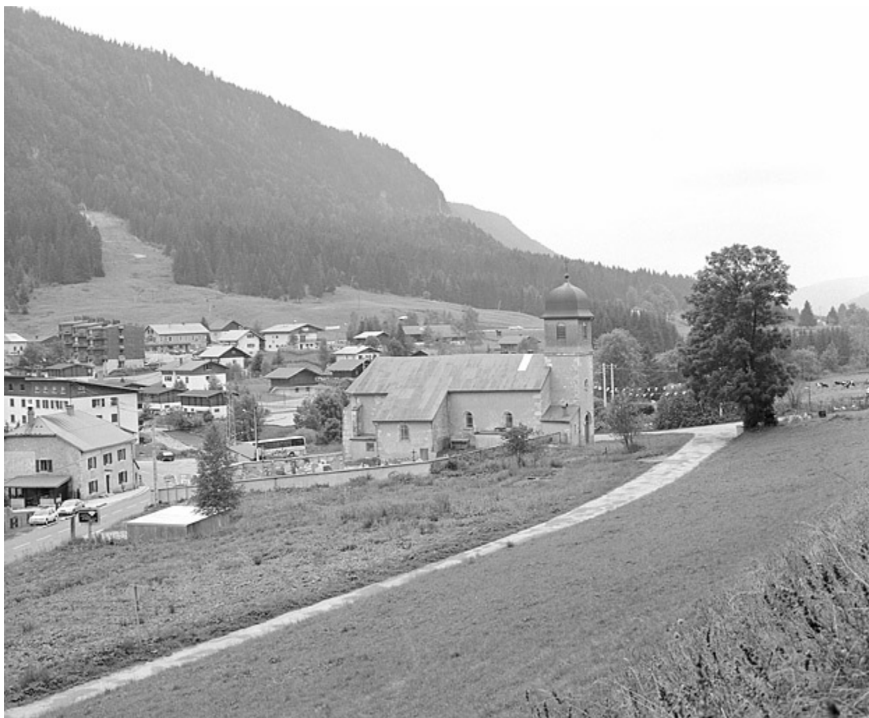
Vue de situation depuis le nord.
