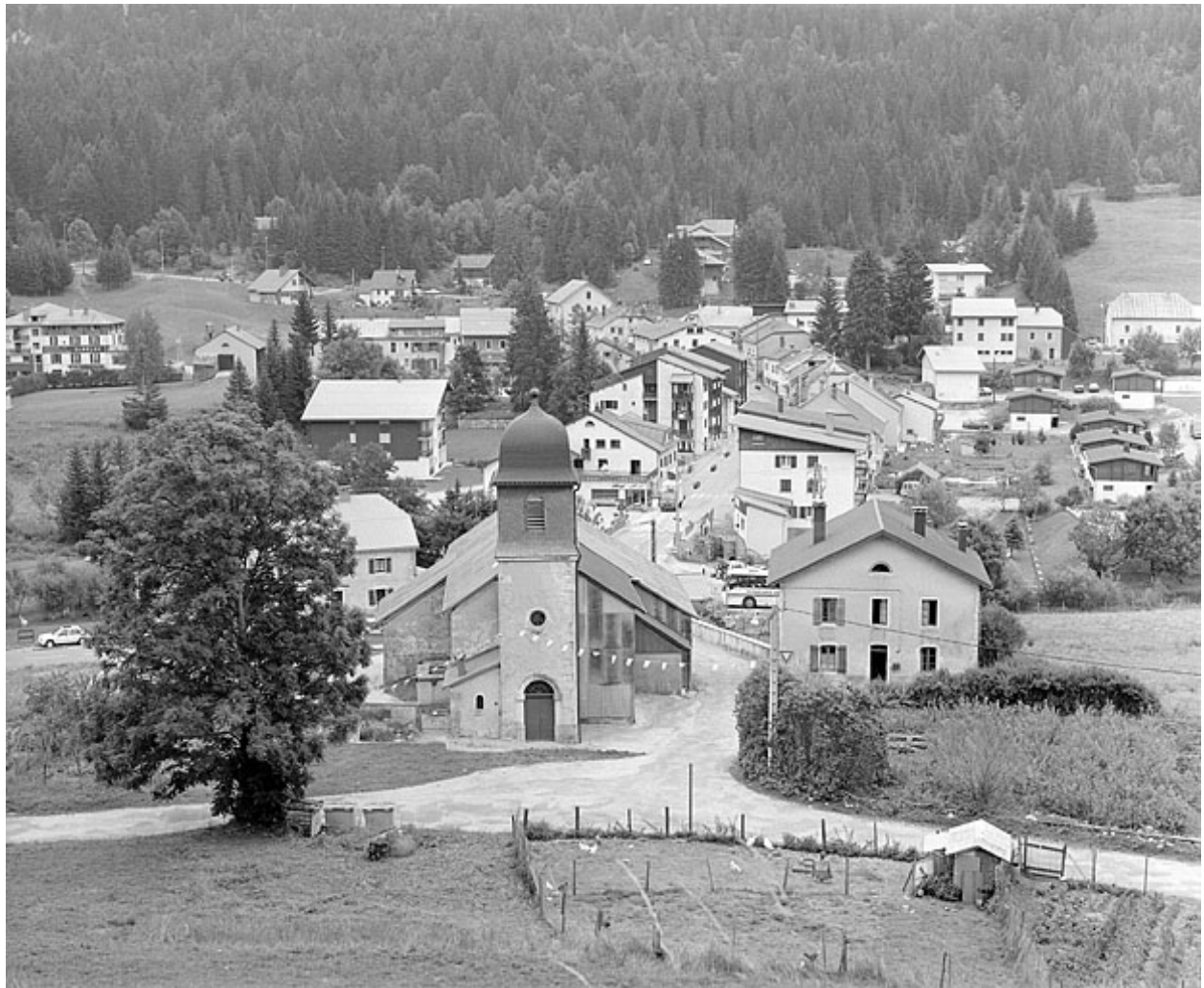
Vue de situation depuis l'ouest (vue horizontale).
