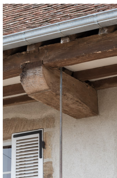
Solve formant encorbellement et permettant, de soutenir le débord de toit destiné à abriter la galerie.
