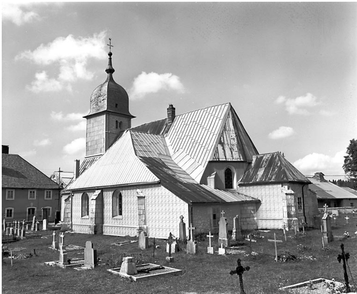
Façades postérieure et latérale droite.
