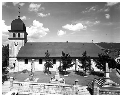
Façade latérale droite. Phot. Jérôme Mongreville IVR43_20003900643V
