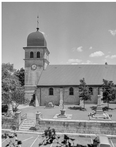
Façade latérale droite. Phot. Yves Sancey IVR43_19993900065XA
