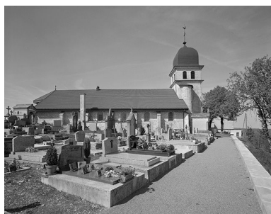
Façade latérale gauche. Phot. Jérôme Mongreville IVR43_20003900641V
