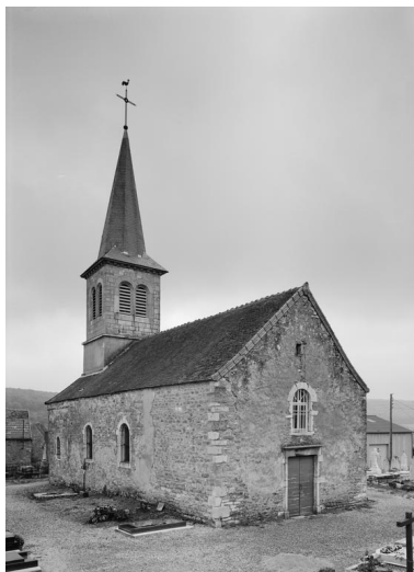
Vue d'ensemble de 3/4 gauche. Phot. Michel Thierry IVR26_19782100856V
