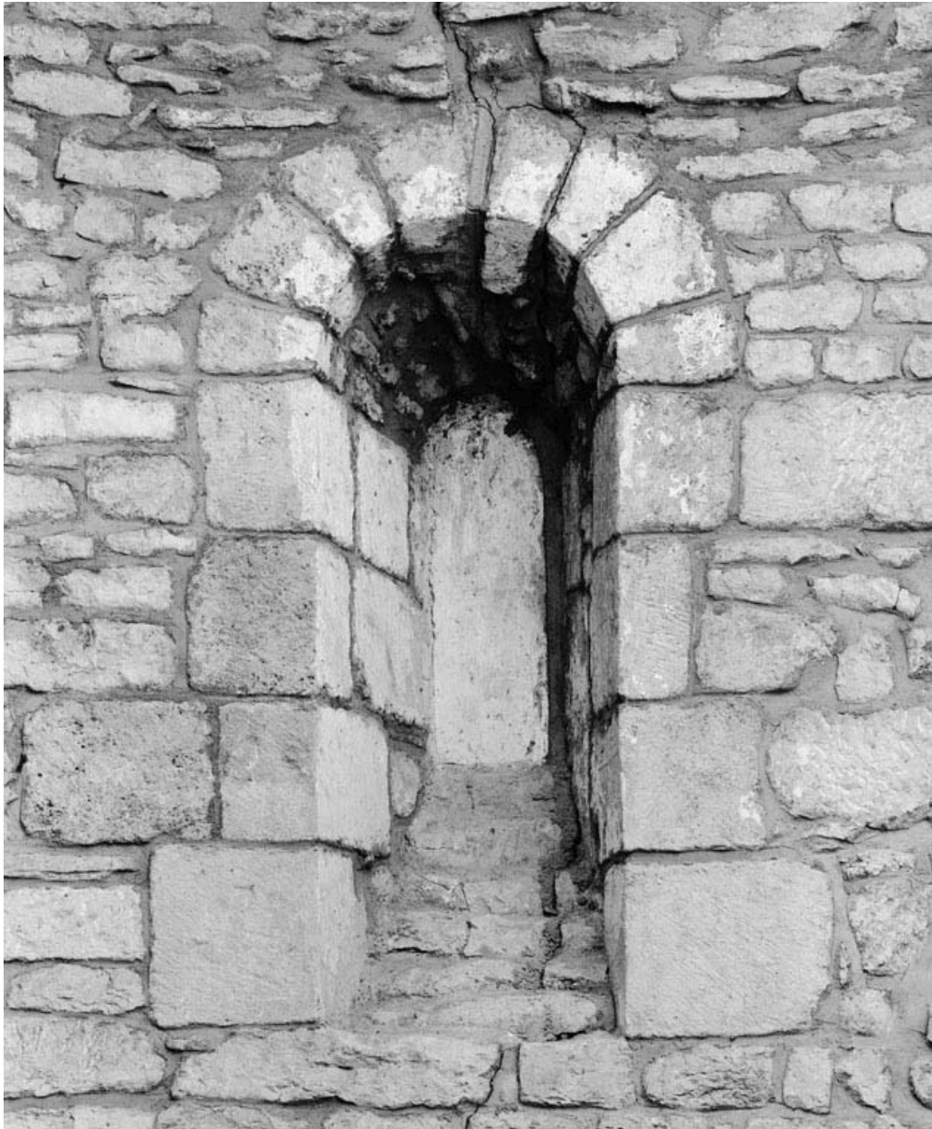
Détail d'une petite baie murée du chœur.
