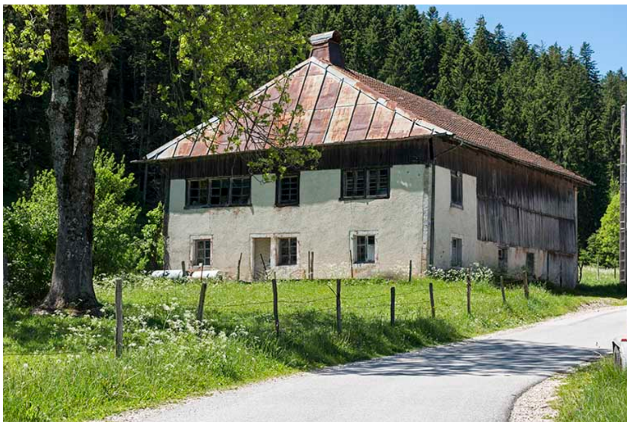
Façades nord et est.
