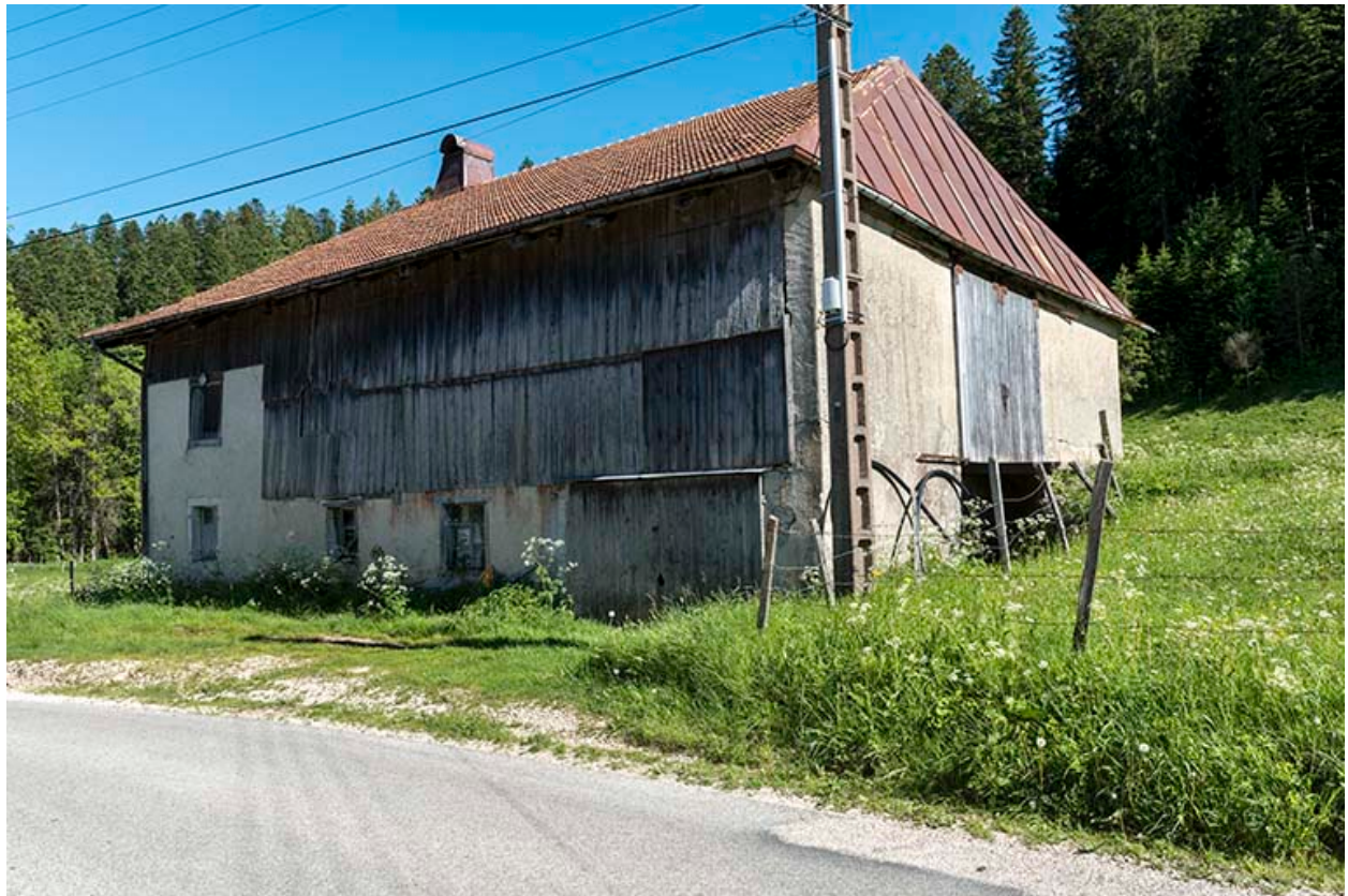
Façades nord et ouest.
