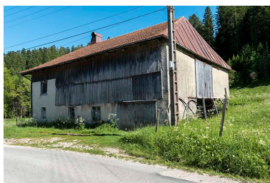
Façades nord et ouest. Phot. Sonia Dourlot IVR43_20172500609NUC4A
