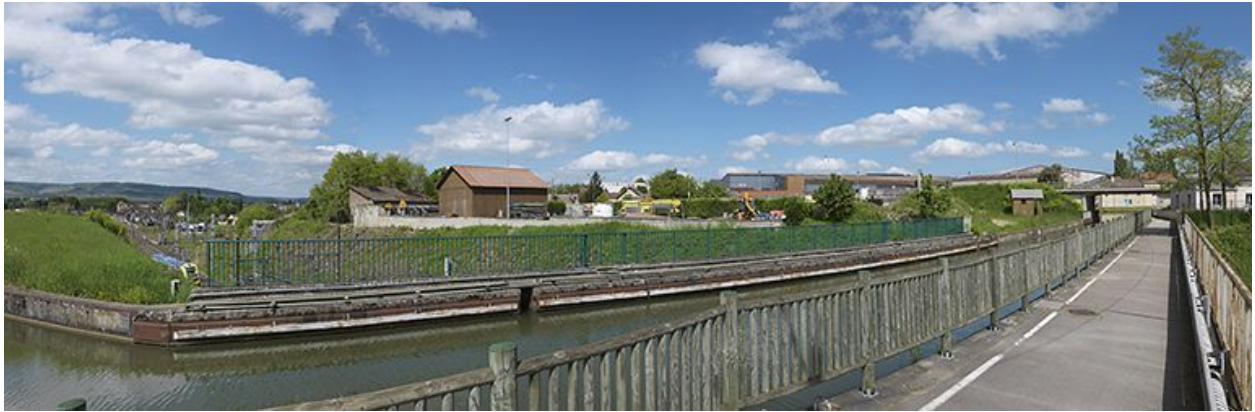
Vue d'ensemble. A gauche, la gare et l'église de Chagny. A droite, la tuilerie et le pont.
