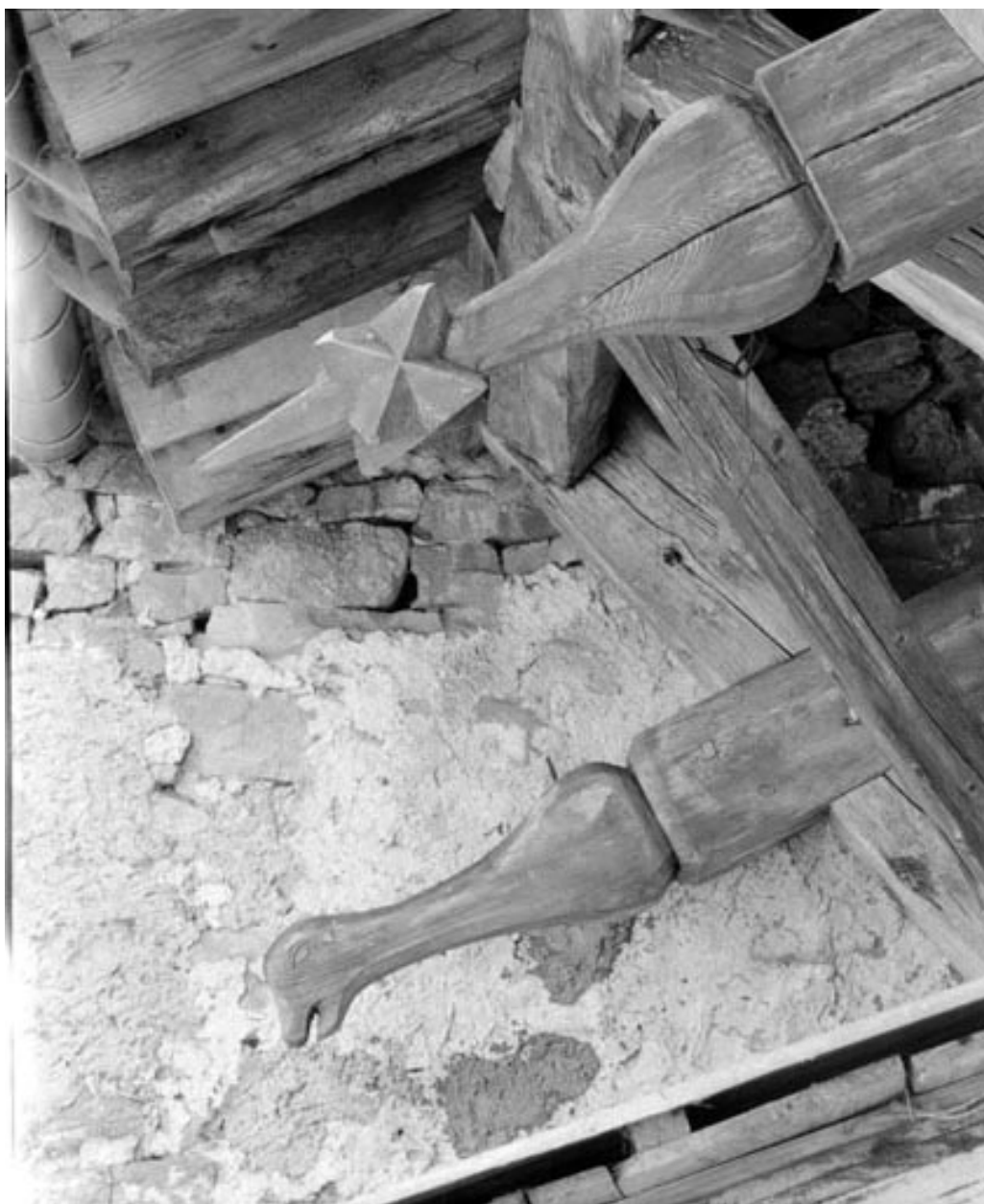
Détail : extrémité d'arbalétriers sculptés.
