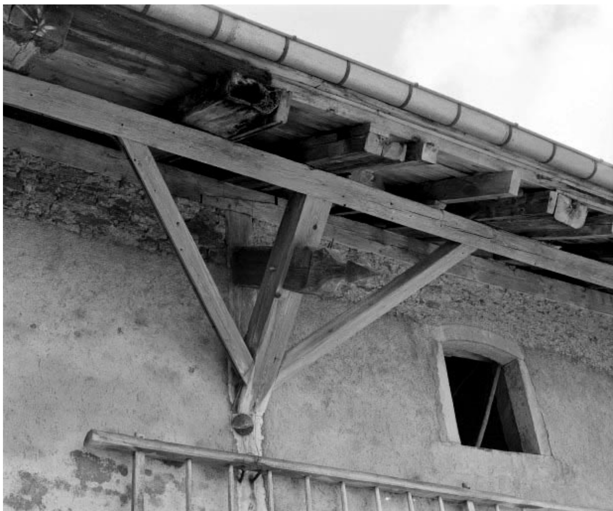
Détail: extrémité d'arbalétrier et assemblage de charpente.
