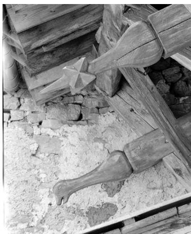
Détail : extrémité d'arbalétriers sculptés. Phot. Yves Sancey
