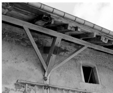
Détail: extrémité d'arbalétrier et assemblage de charpente. Phot. Yves Sancey IVR43_19772500364X
