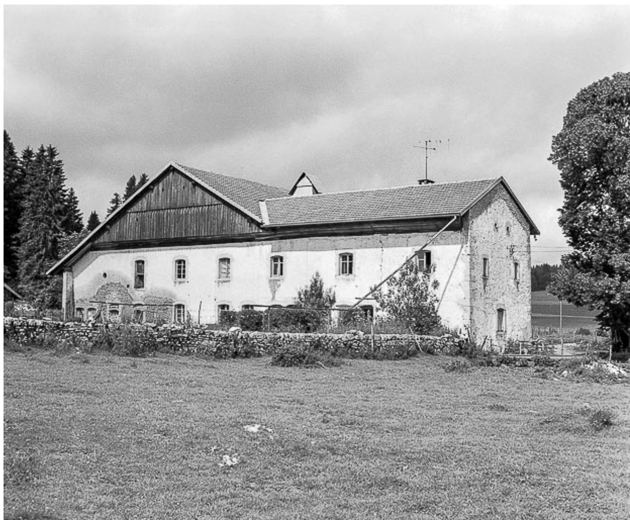
Façades antérieure et latérale droite.
