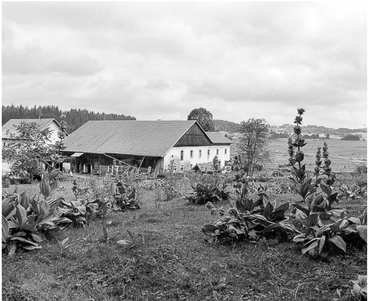
Façades antérieure et latérale gauche.
