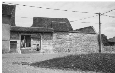
Vue d'ensemble depuis la rue. Phot. Bernard Lardière IVR43_19817000196Z
