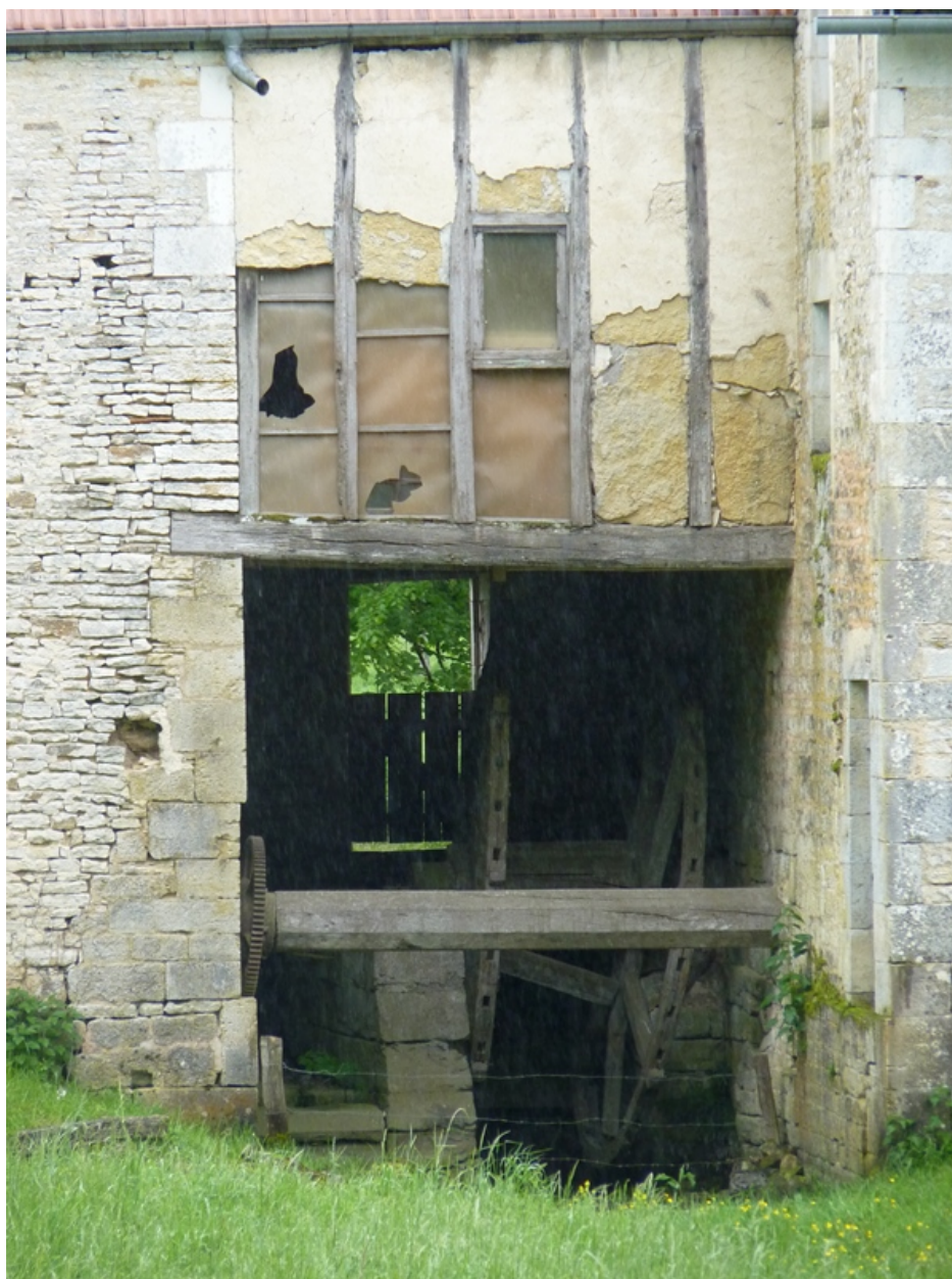
Détail du bief et de la roue du moulin, surmontés d'un niveau en pan de bois.
