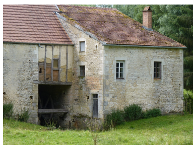
Détail de la jonction entre les deux parties du moulin (élévation nord). Phot. Baptiste Quost IVR26_20162100648NUC2A
