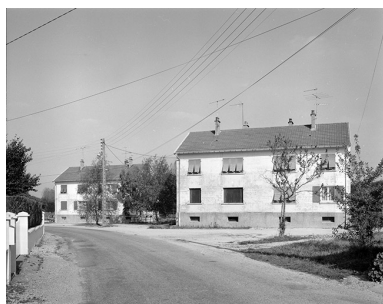
Immeubles semblables, rue Victor Hugo. Phot. Yves Sancey IVR43_19893900572X
