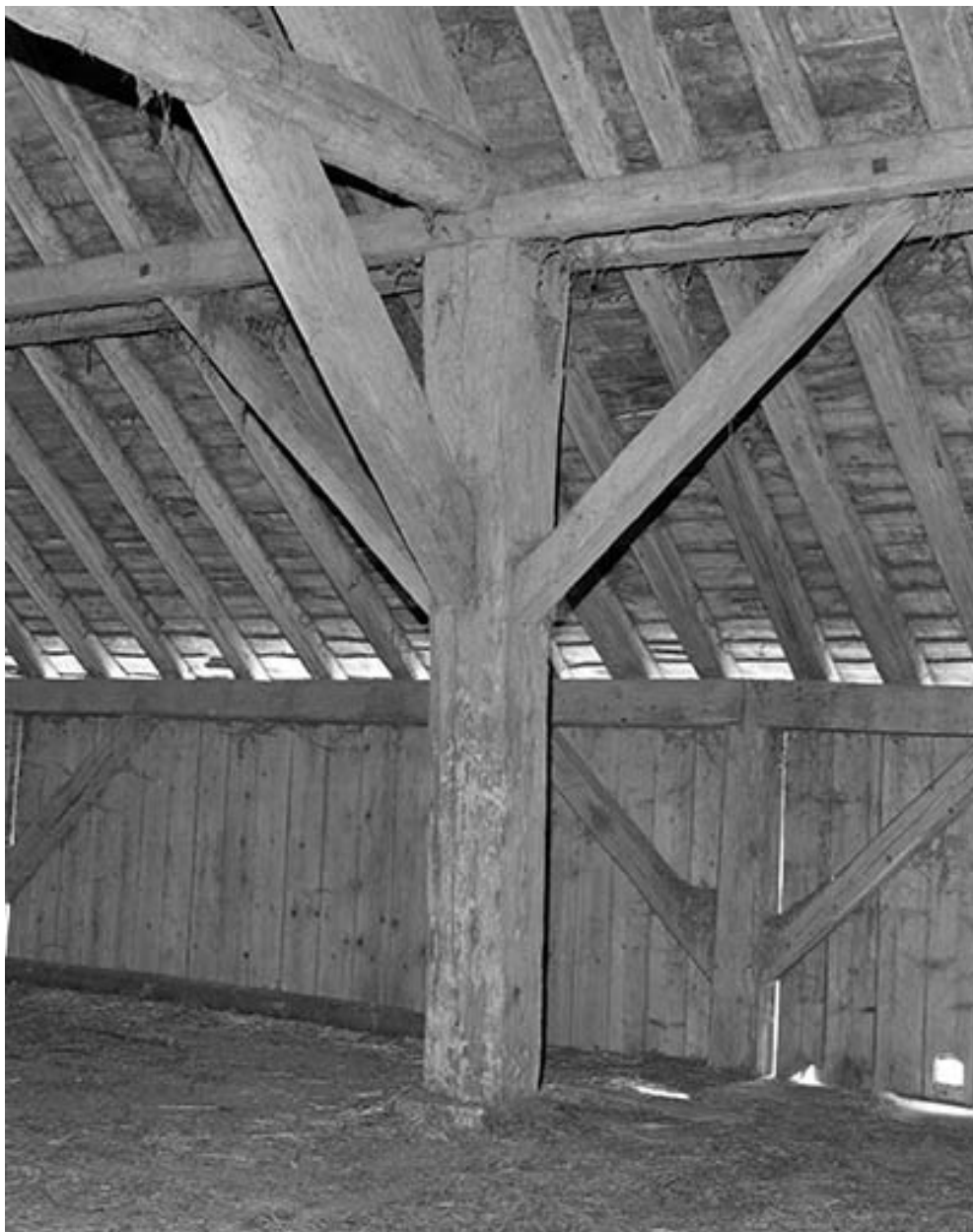
Charpente, partie inférieure au niveau d'une ferme.
