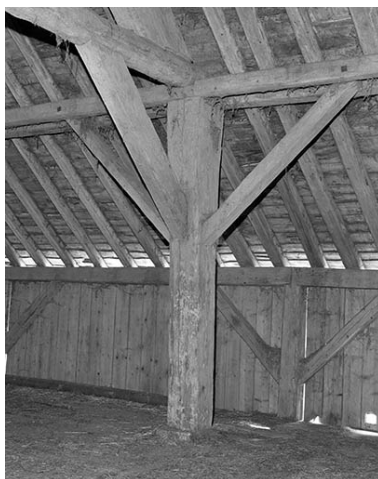
Charpente, partie inférieure au niveau d'une ferme. Phot. Dominique Dominguez IVR43_19792500277X
