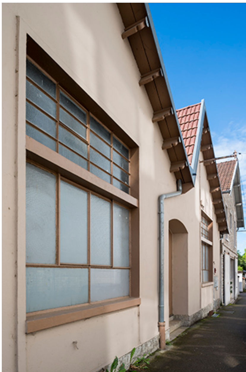
Détai des murs-pignons des sheds.
