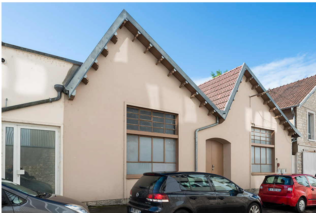
Murs-pignons des sheds sur le rue Klein.
