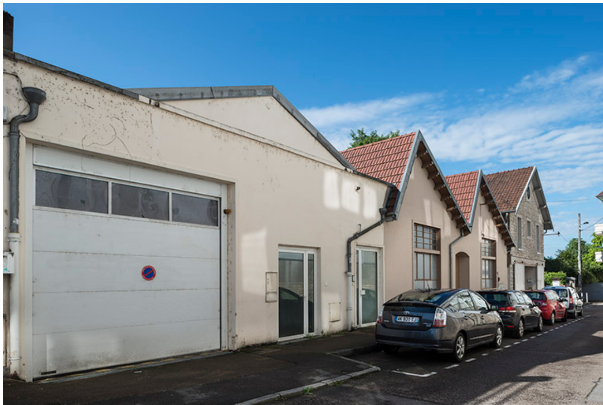
Façades postérieures (rue Klein).
