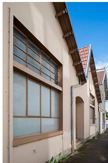
Détai des murs-pignons des sheds. Phot. Jérôme Mongreville IVR43_20182500671NUC4A
