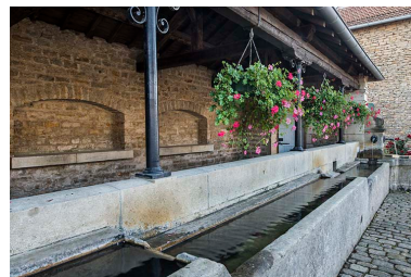
Les abreuvoirs et la colonne métallique. Phot. Jérôme Mongreville IVR43_20167001643NUC4A
