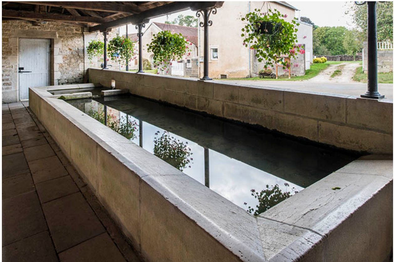
Le bassin à usage de lavoir.
