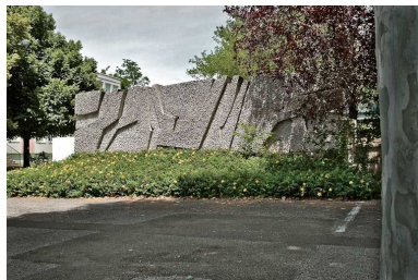
Vue d'ensemble. Phot. Jean-Luc Duthu IVR26_20092100387NUC2A
