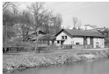
Ateliers de fabrication et logement d'ouvriers. Phot. Laurent Poupard IVR43_19893901240Z
