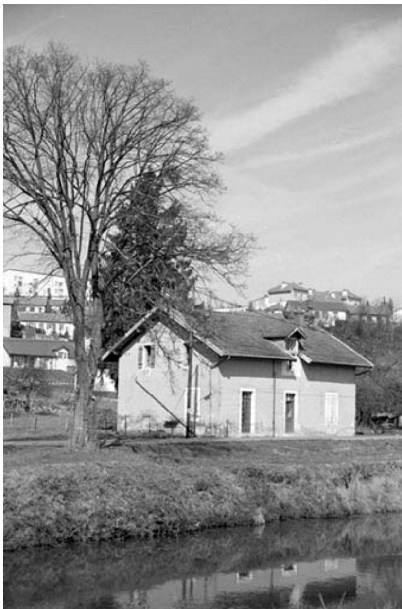
Bureau et logement d'ouvriers.
