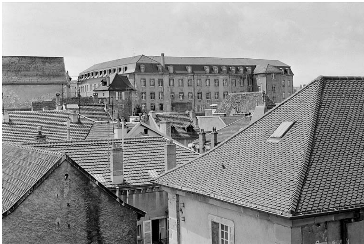
Vue d'ensemble, côté nord.
