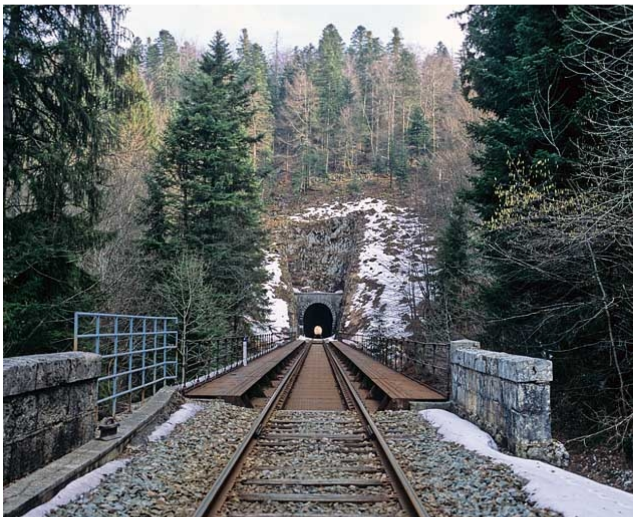
Vue d'ensemble depuis la voie, côté Andelot-en-Montagne.
