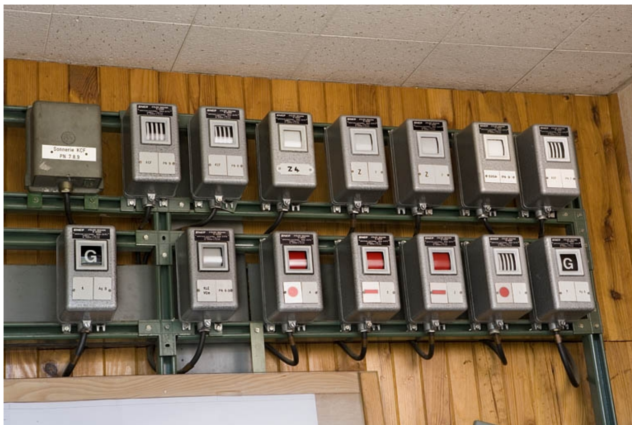
Galleries de répéteurs optiques et sonnerie.
