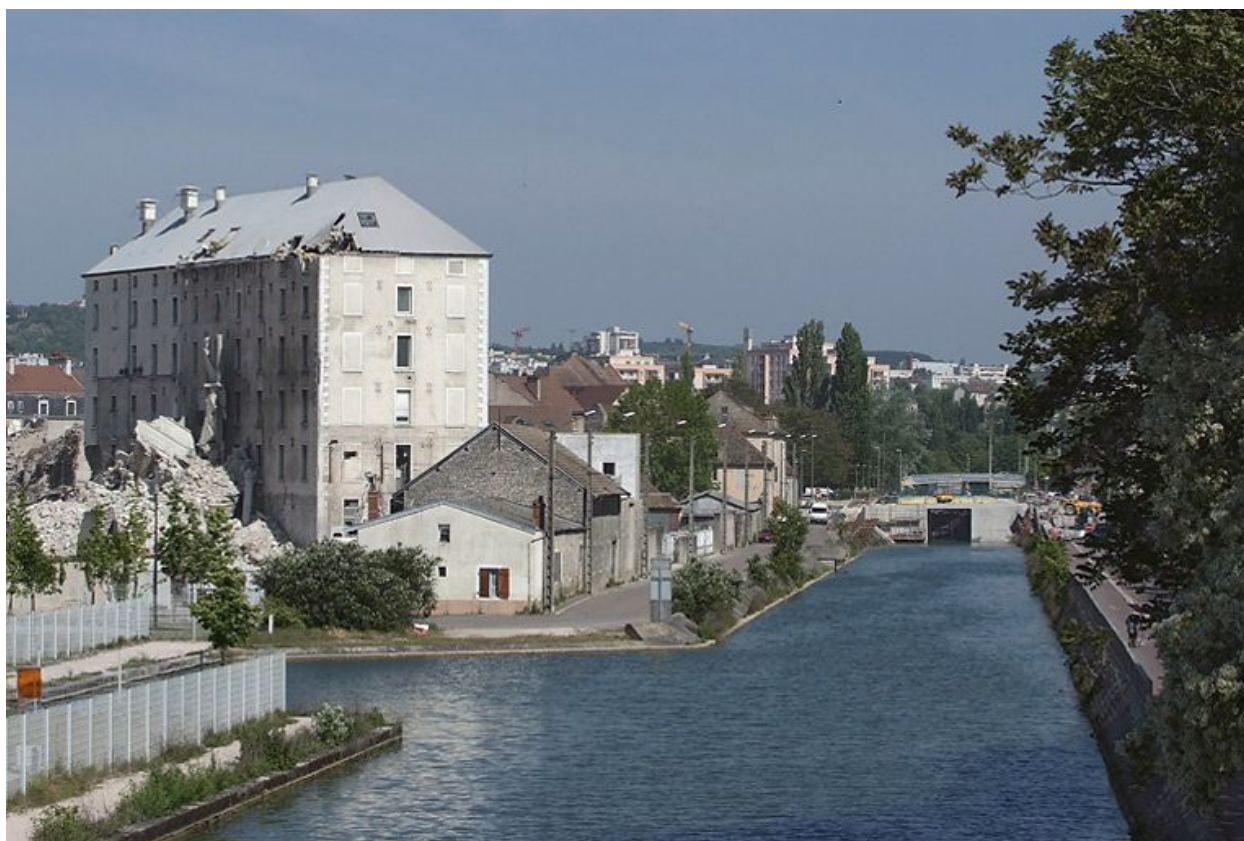
Les bâtiments en cours de démolition.
