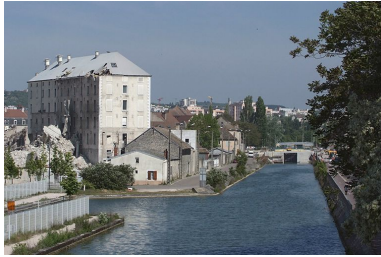
Les bâtiments en cours de démolition.
