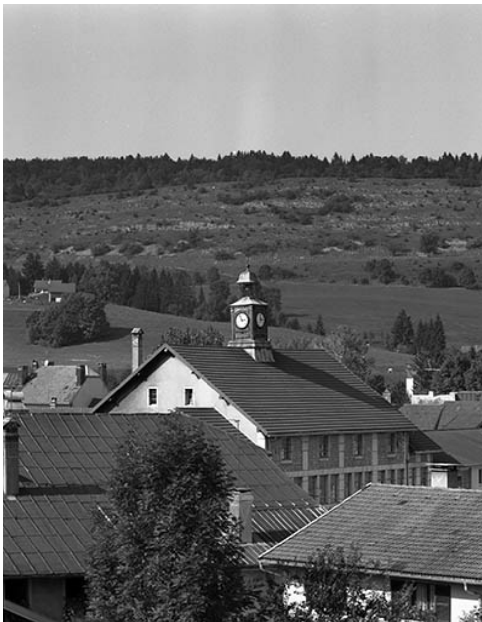
La toiture de l'usine depuis le sud-est.
