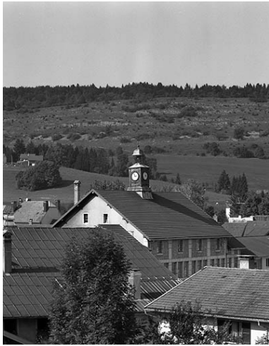
La toiture de l'usine depuis le sud-est.
