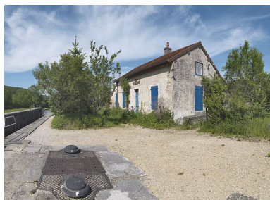
Maison éclusière de 3/4. Phot. Thierry Kuntz IVR26_20122102400NUC4AQ
