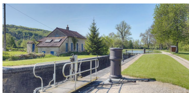
Vue d'ensemble de l'aval. Phot. Thierry Kuntz IVR26_20122102398NUC4AQ
