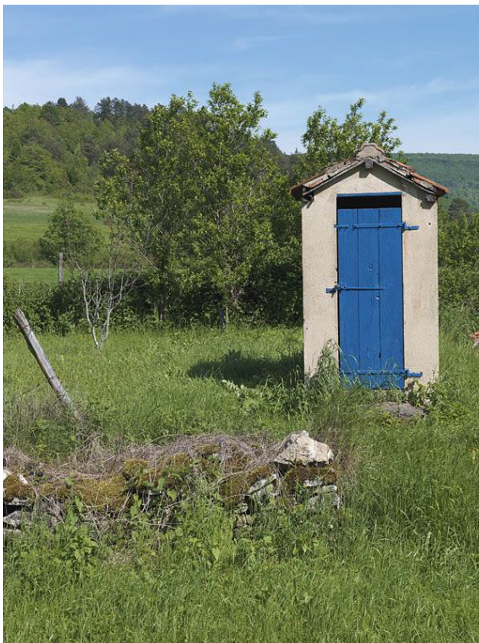
Les latrines de la maison éclusière.
