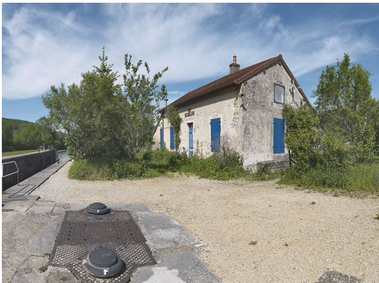
Maison éclusière de 3/4.
