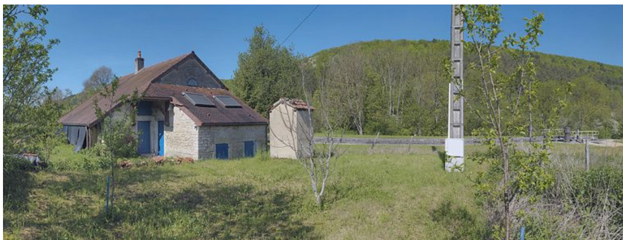
Les annexes de la maison éclusière.
