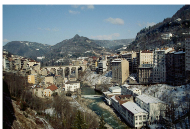
Vue d'ensemble du site depuis le sud-ouest. Phot. Laurent Poupard IVR43_19923901364ZA
