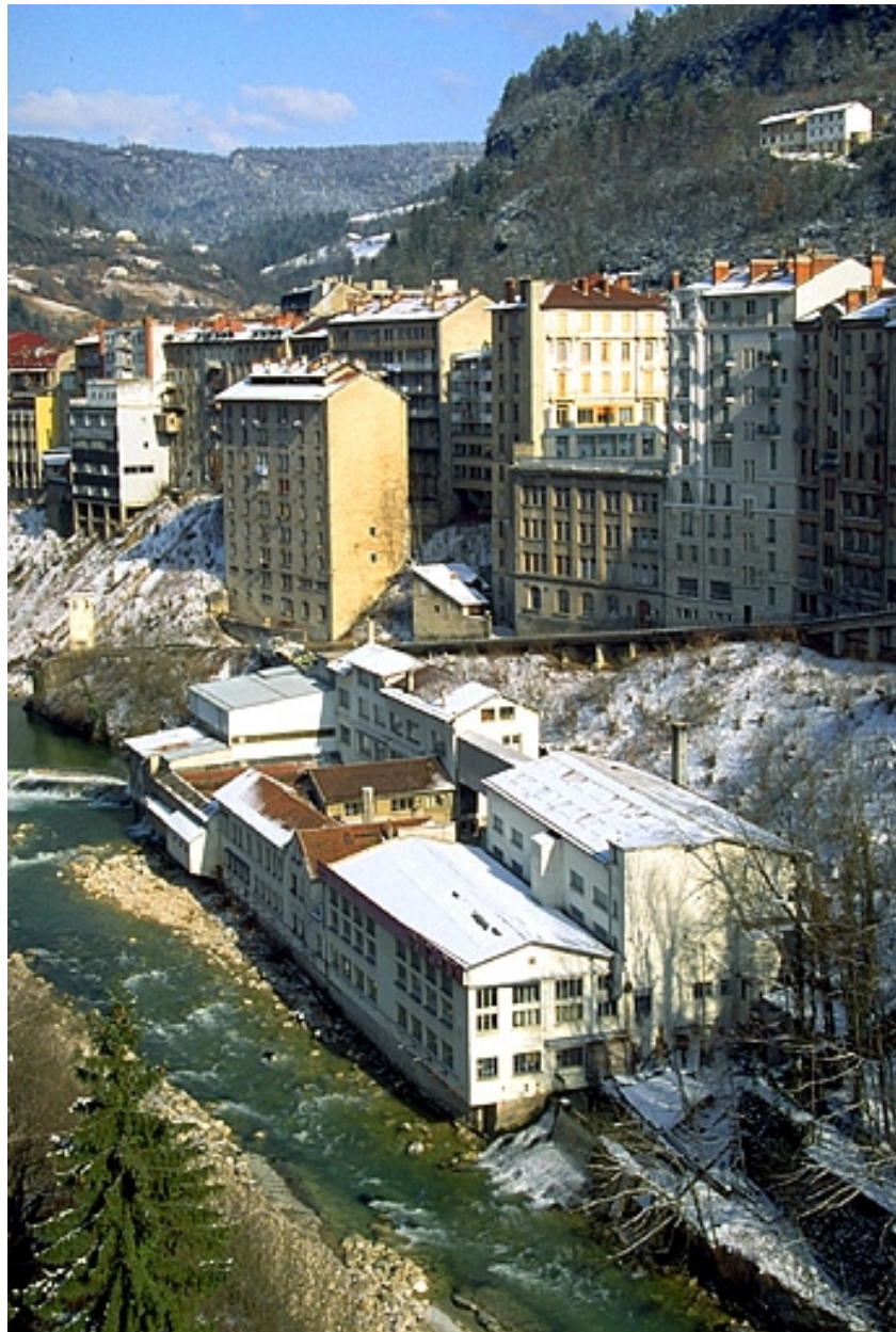
Vue plongeante depuis le sud-ouest.
