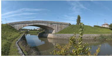
Vue d'ensemble prise d'aval. Phot. Thierry Kuntz IVR26_20112103376NUC4A
