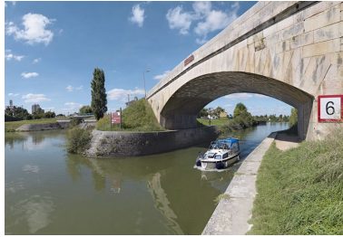
Vue d'aval. Phot. Thierry Kuntz IVR26_20112103378NUC4A
