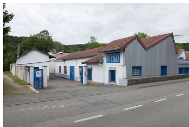
Bureau et atelier depuis le sud-est. Phot. Jérôme Mongreville IVR43_20122501057NUC4A
