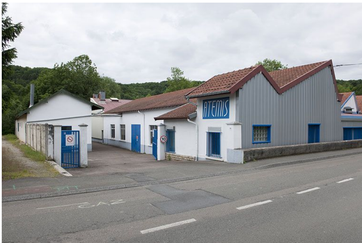
Bureau et atelier depuis le sud-est.
