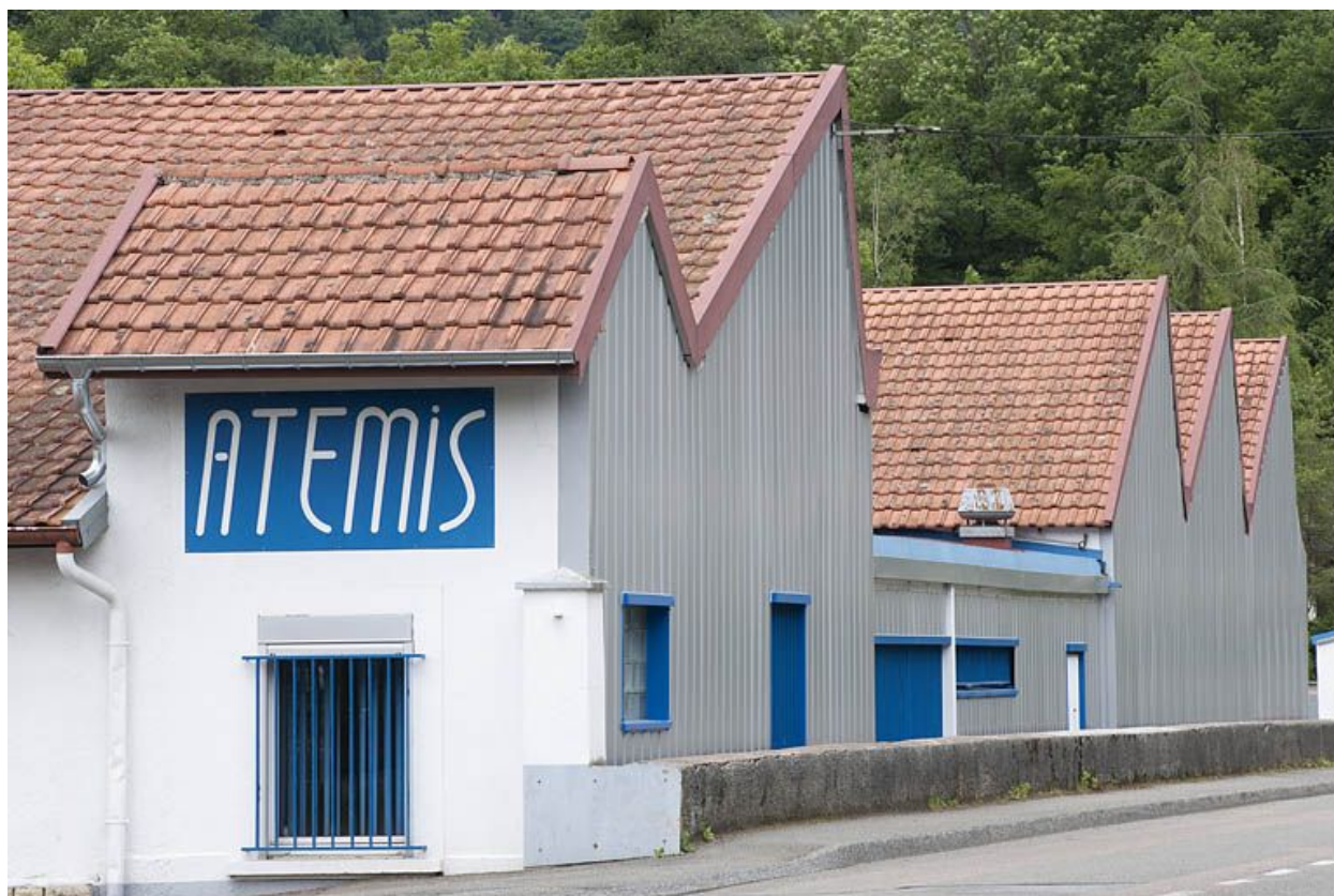
Pignons des sheds sur la route.
