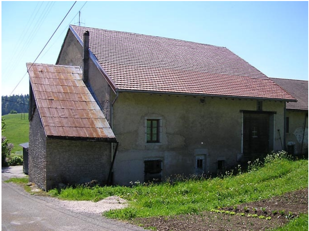
Façade postérieure et remise.
