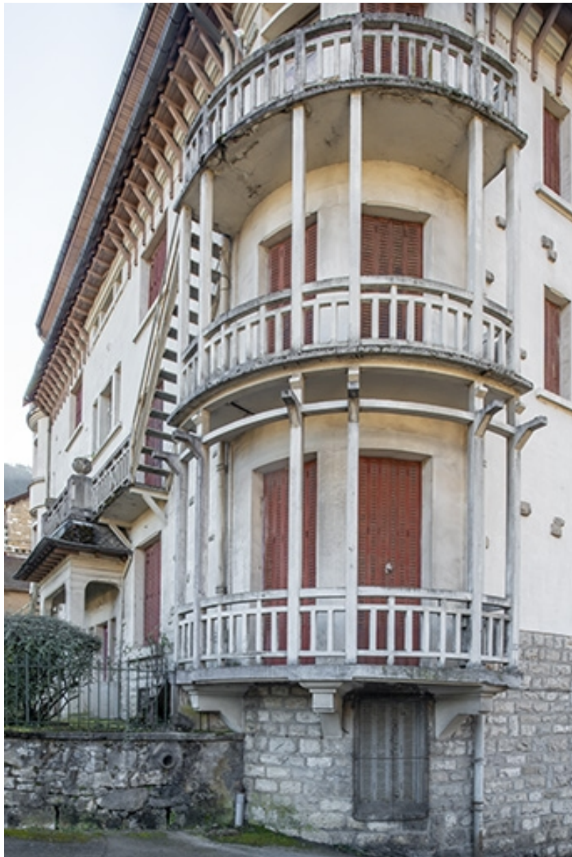
Balcons de l'angle nord-ouest.
