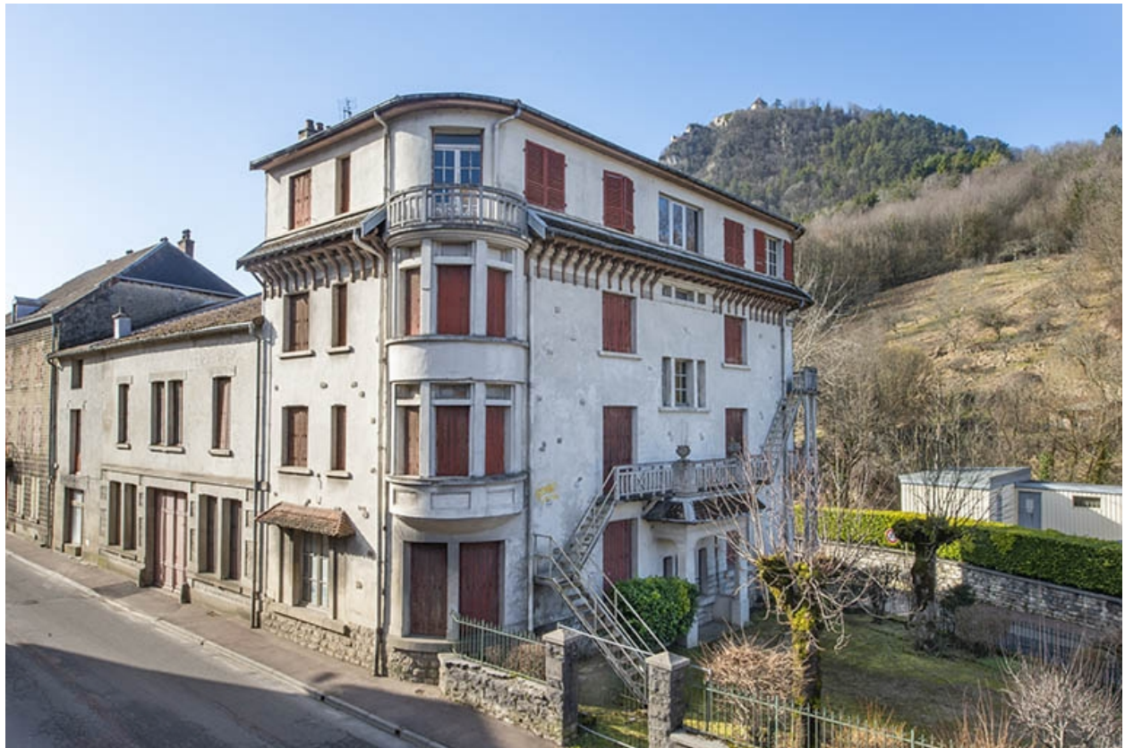
Vue depuis le nord-est.
