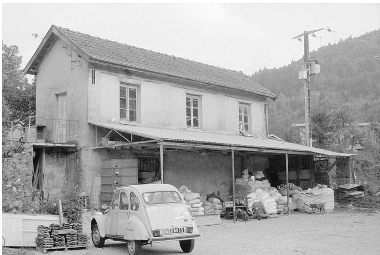
Ancien atelier de fabrication.
