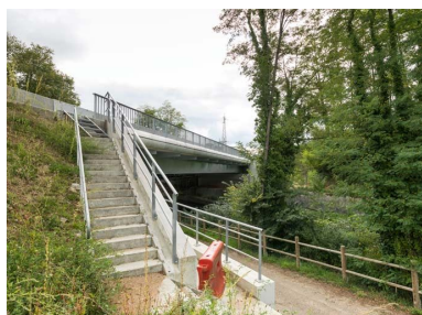
Vue d'ensemble du pont.
