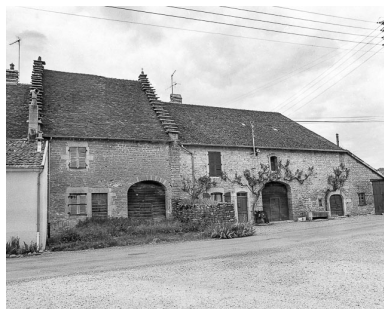
Fermes situées rue Roche. Phot. Yves Sancey IVR43_19813900278X
