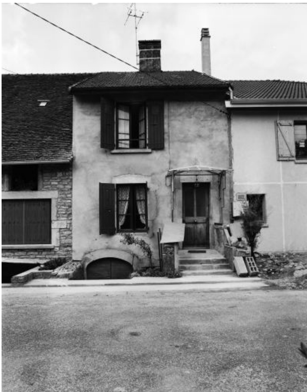
Maison de vigneron située rue Roche.
