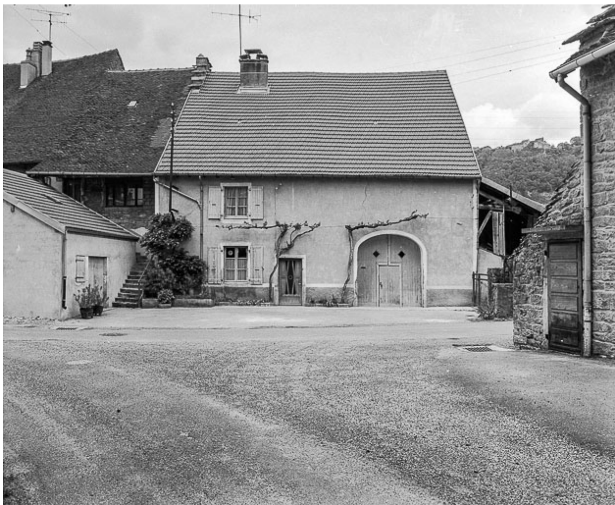
Ferme située rue du Chalet.
