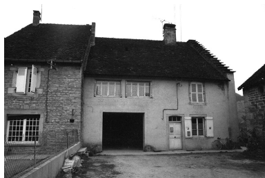
Ferme située rue des Guichard. Phot. F. Pernin IVR43_19743900151Z
