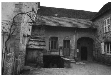
Maison de vigneron située rue du Presbytère. Phot. F. Pernin IVR43_19743900153Z
