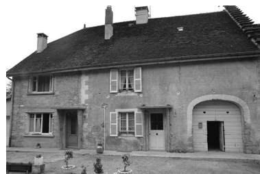
Maison située rue des Guichard. Phot. F. Pernin IVR43_19743900119Z
