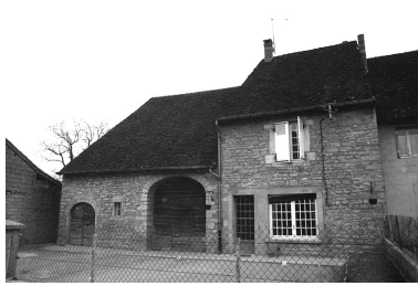
Ferme située rue des Guichard. Phot. F. Pernin IVR43_19743900150Z
