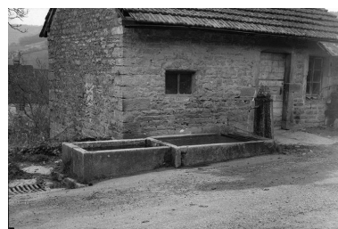
Fontaine : vue d'ensemble. Phot. F. Pernin IVR43_19743900155Z
