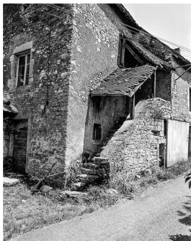
Détail de l'escalier. Phot. Dominique Humbert IVR43_19767000446X
