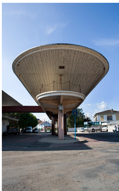
Station bus avec auvents. Phot. Yves Sancey IVR43_20067000887NUCA
