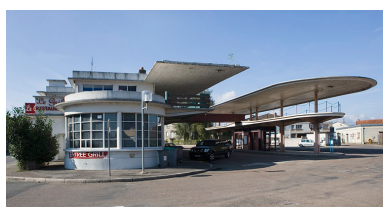
Gare et auvents. Phot. Yves Sancey IVR43_20067000886NUCA
