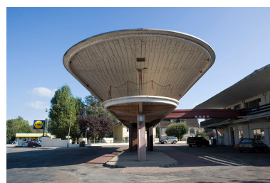
Auvent en béton. Phot. Yves Sancey IVR43_20067000890NUCA
