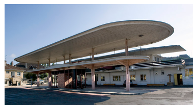
Station bus avec auvents. Phot. Yves Sancey IVR43_20067000889NUCA
