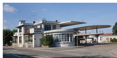
Gare et auvents. Phot. Yves Sancey IVR43_20067000885NUCA
