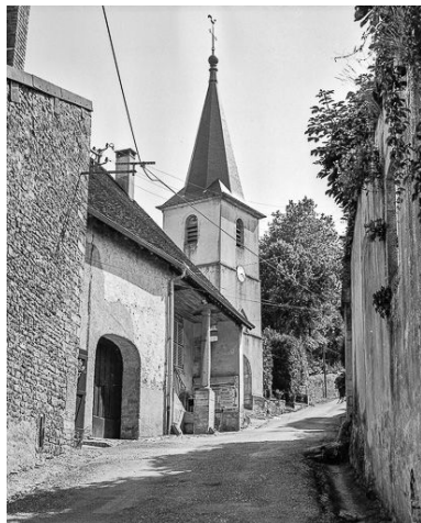
Façade antérieure : vue d'ensemble de trois quarts.
