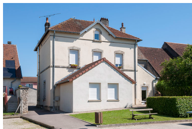
Façade postérieure avec l'agrandissement contemporain. Phot. Jérôme Mongreville IVR43_20167001021NUC4A
