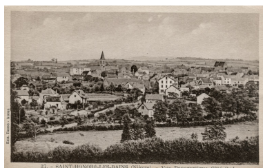
Vue panoramique du bourg. Autr. auteur inconnu IVR26_20195800121NUC2A
