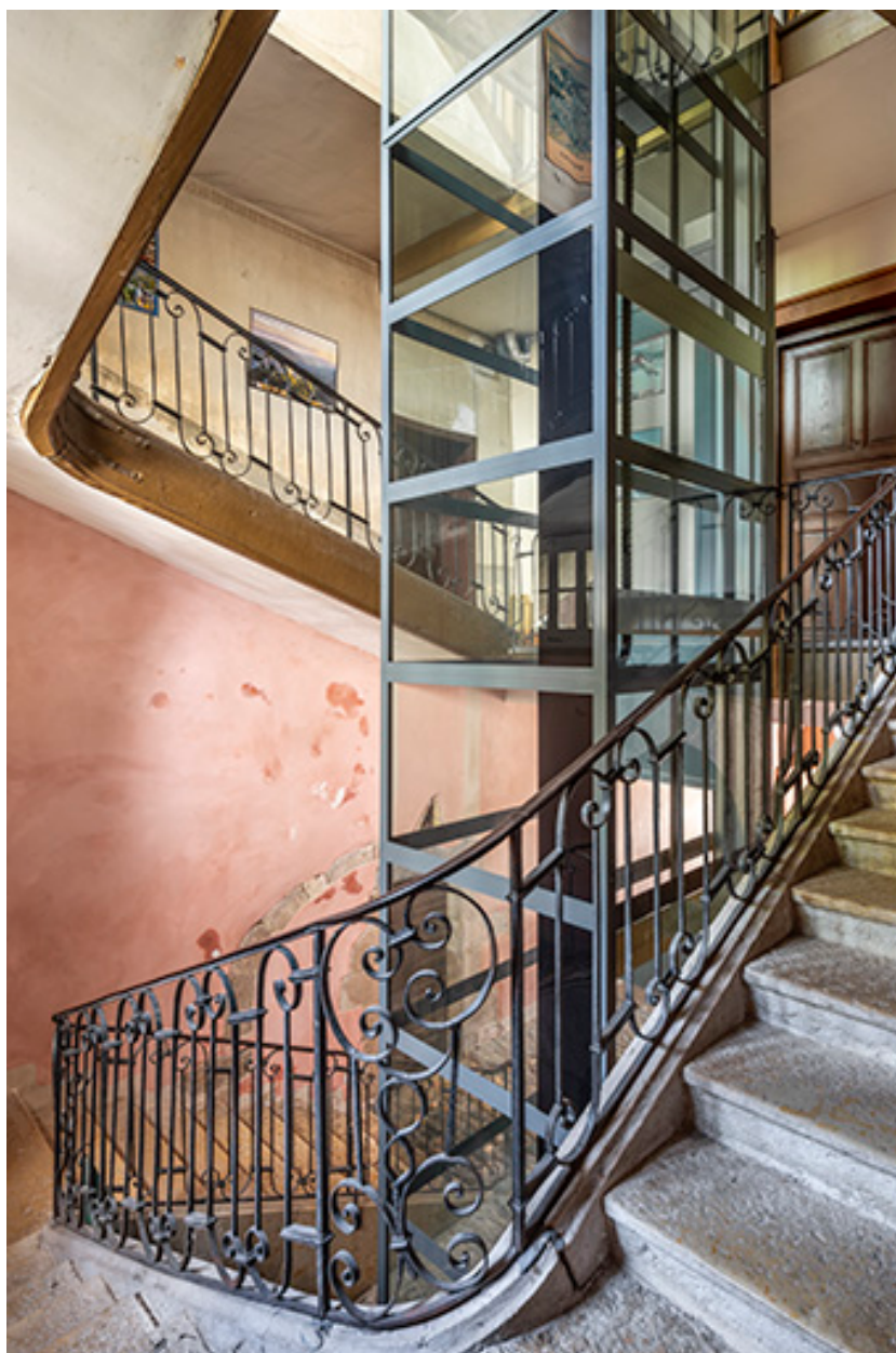
La cage d'escalier depuis le second repos.
