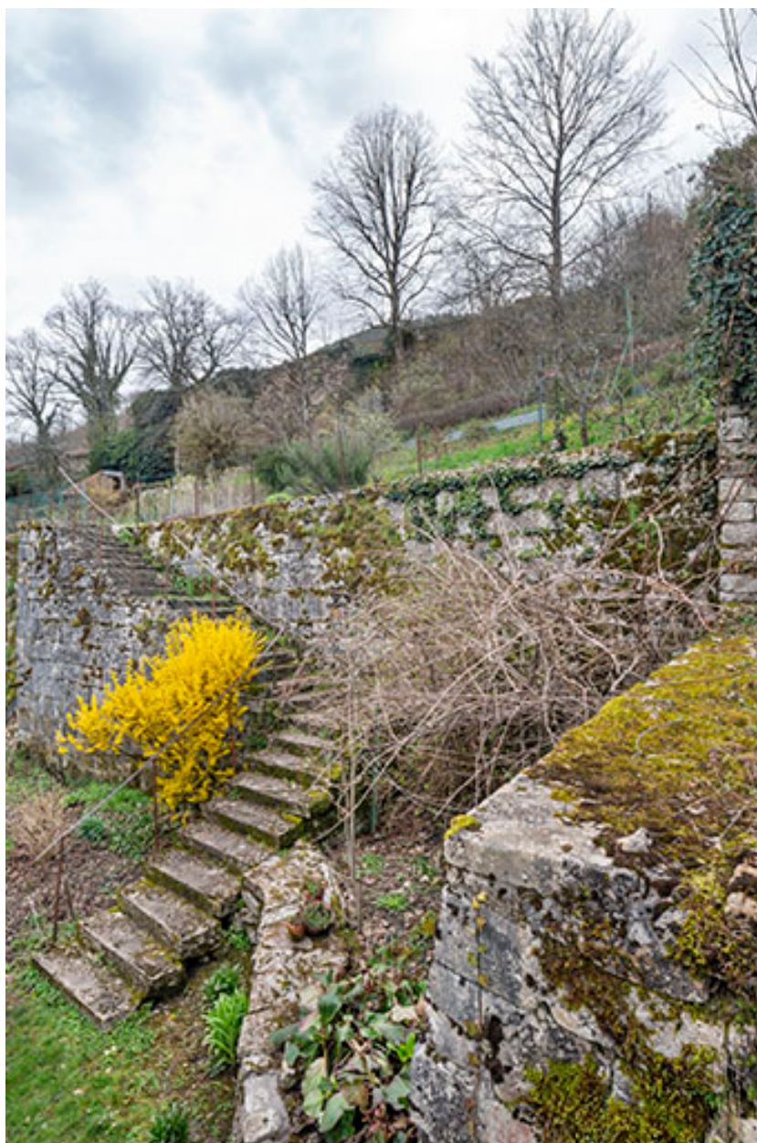
L'escalier d'accès à la première terrasse.
