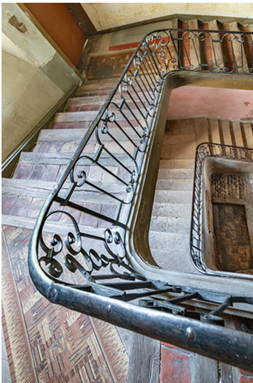
Vue plongeante sur la cage d'escalier.
