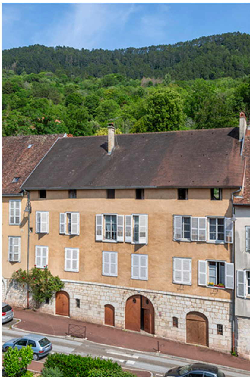
Façade antérieure vue depuis l'ouest.
