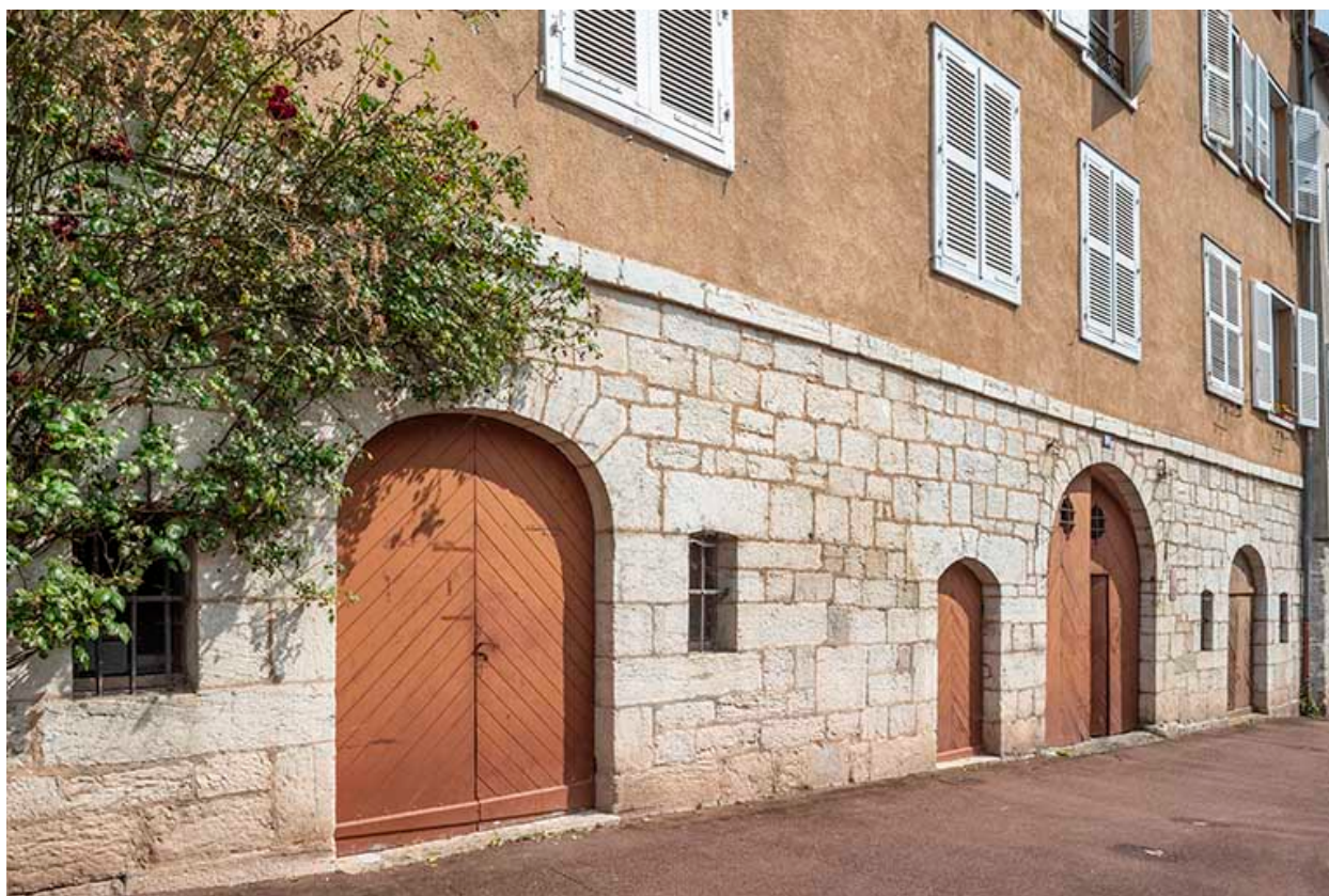
Les ouvertures au rez-de-chaussée.
