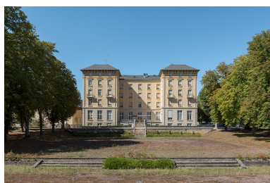
Façade principale sur le parc. Phot. Pierre-Marie Barbe-Richaud IVR26_20192100308NUC4A
