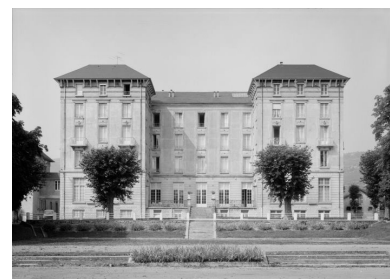
Façade, état en 1979. Phot. Michel Thierry IVR26_19792101483V
