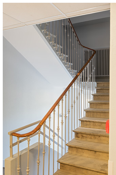
Escalier sud-ouest. Phot. Pierre-Marie Barbe-Richaud IVR26_20192100299NUC4A
