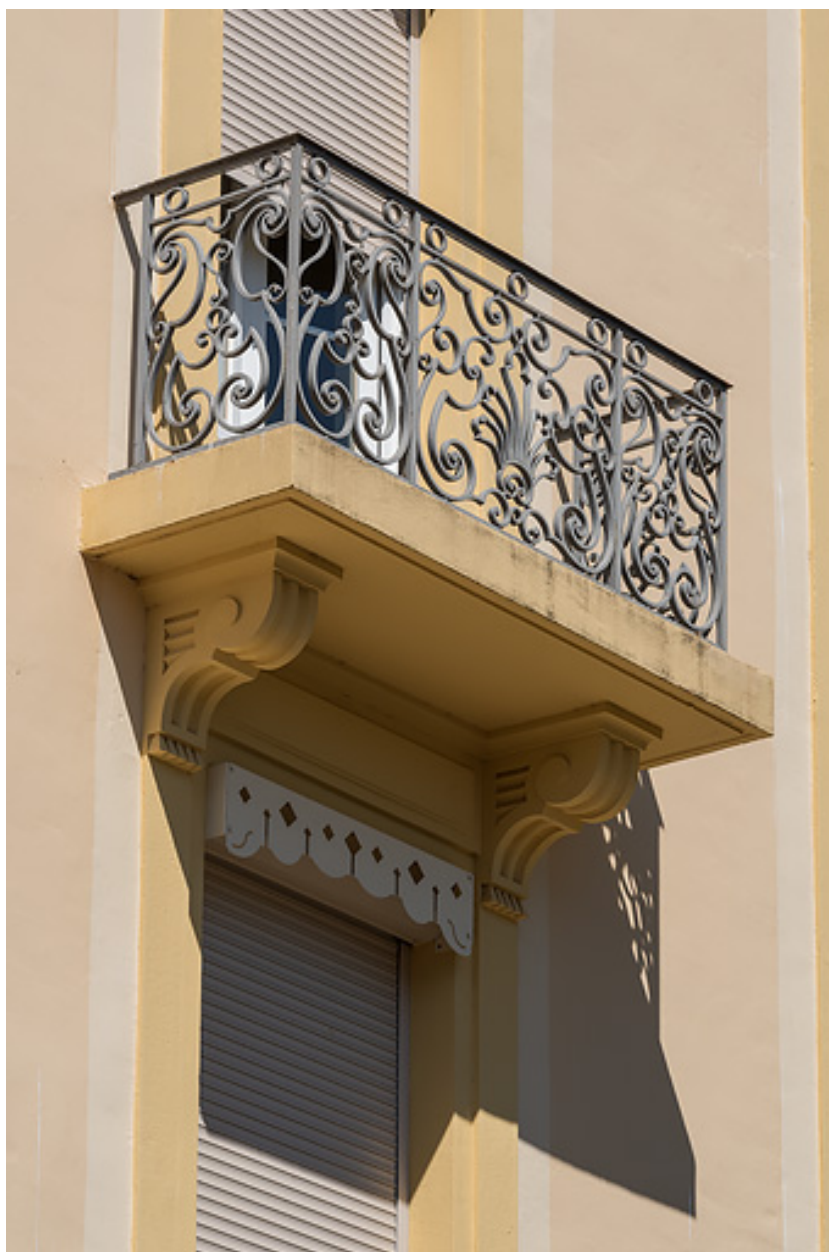
Balcon à l'extrémité est de l'aile nord.
