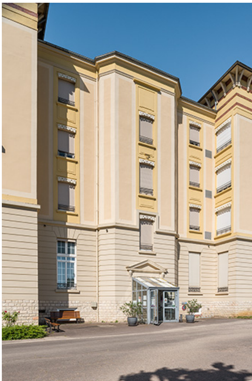
Façade nord-est avec l'entrée de l'escalier.
