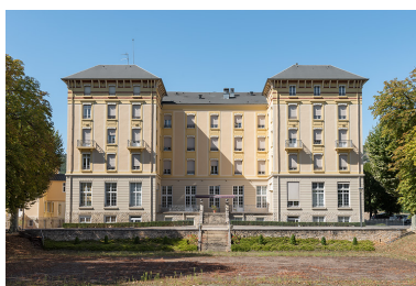
Façade principale sur le parc. Phot. Pierre-Marie Barbe-Richaud IVR26_20192100309NUC4A
