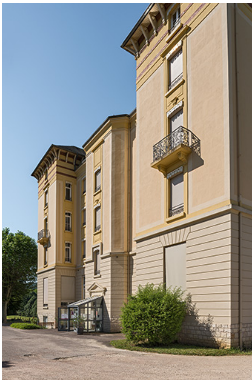
Façade nord-est avec l'entrée de l'escalier.
