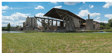
Vue du pont-roulant de la cimenterie. Phot. Pierre-Marie Barbe-Richaud IVR26_20118900303NUC4AQ
