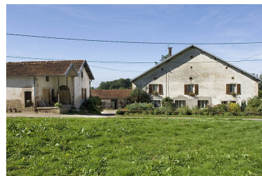
Bâtiments industriels et pignon de la ferme. Phot. Jérôme Mongreville IVR43_20067000768NUCA
