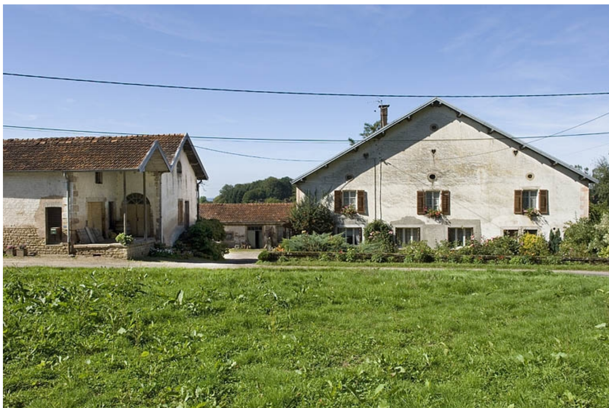
Bâtiments industriels et pignon de la ferme.
