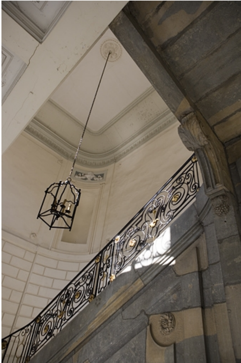
Escalier d'honneur : vue en contre-plongée.
