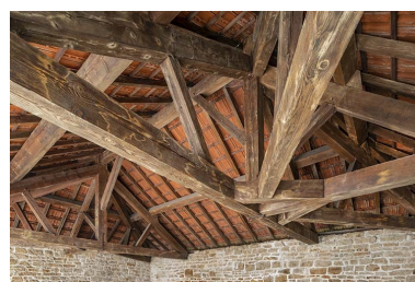
La charpente du lavoir.
