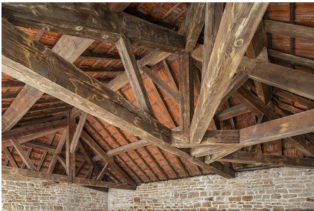
La charpente du lavoir.
