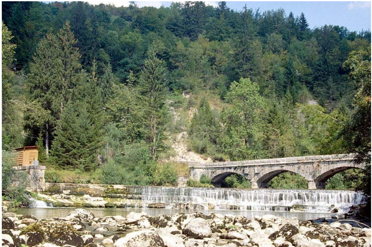
Le barrage, vu de l'aval.
