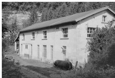
Centrale hydroélectrique. Phot. Laurent Poupard IVR43_19913901153Z
