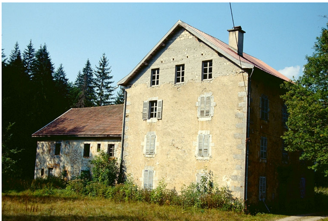
Logement et atelier de fabrication (B, C).
