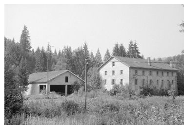
Scierie, logement et atelier de fabrication (E).
