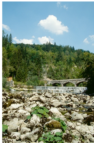
Le barrage, vu de l'aval. Phot. Laurent Poupard IVR43_19913901156ZA
