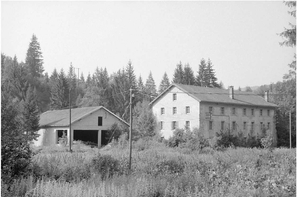
Scierie, logement et atelier de fabrication (E).
