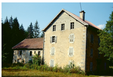
Logement et atelier de fabrication (B, C).
