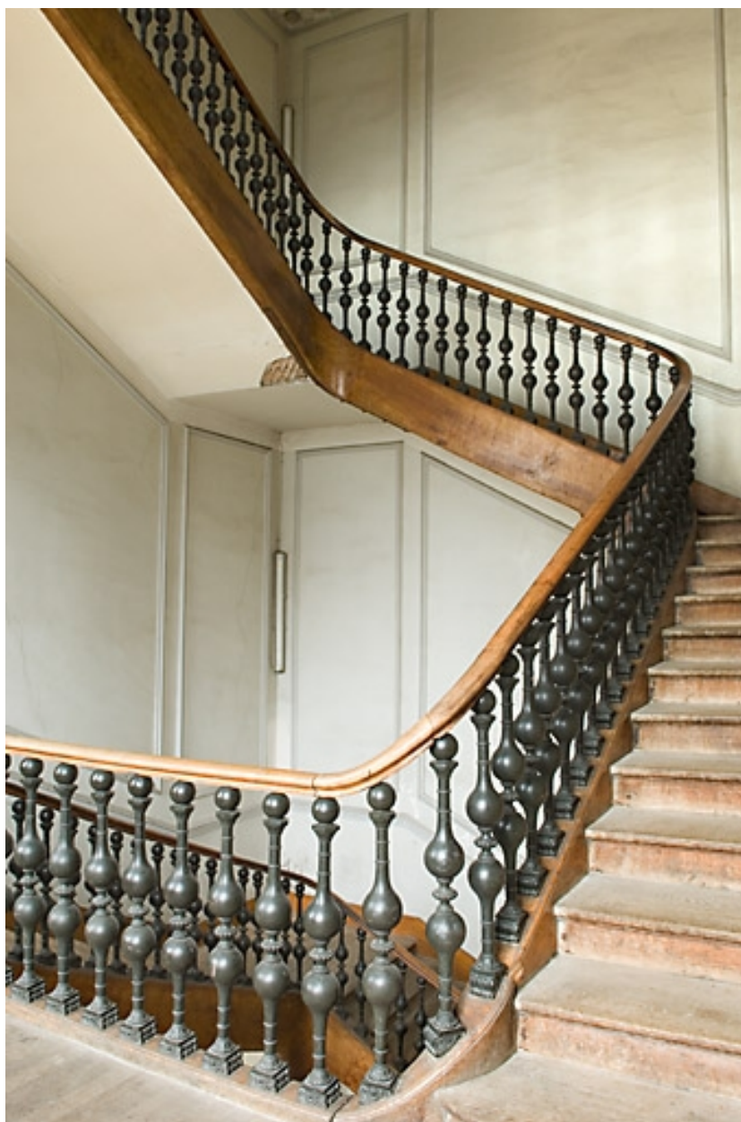
Escalier d'honneur : vue d'ensemble.
