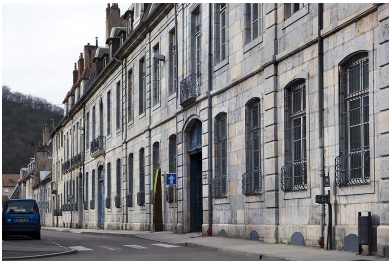
Vue d'ensemble de trois-quart droit.
