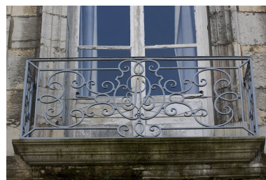
Détail du balcon en fer forgé sur cour. Phot. Yves Sancey IVR43_20072500172NUCA
