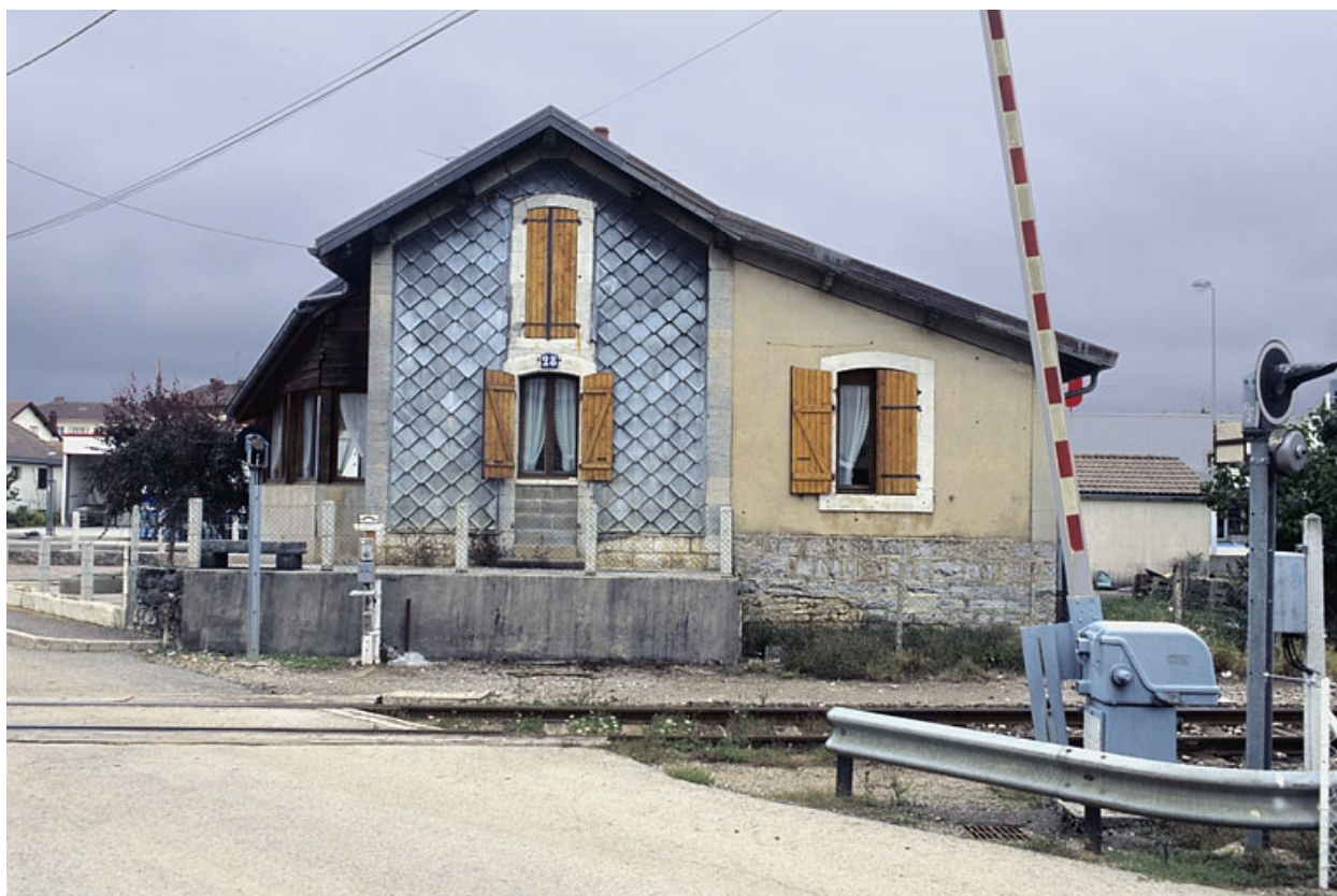
Façade sud (côté voie).
