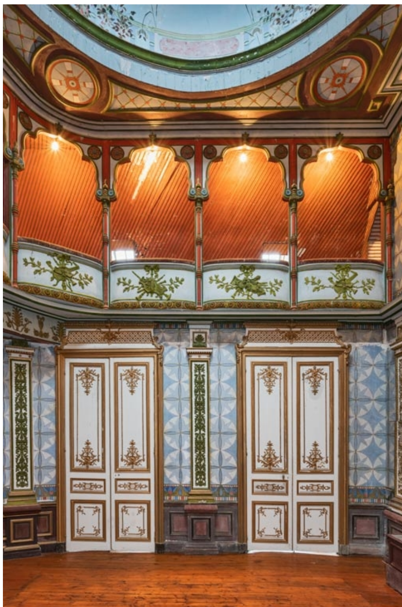
Salle : élévation latérale, avec le balcon.
