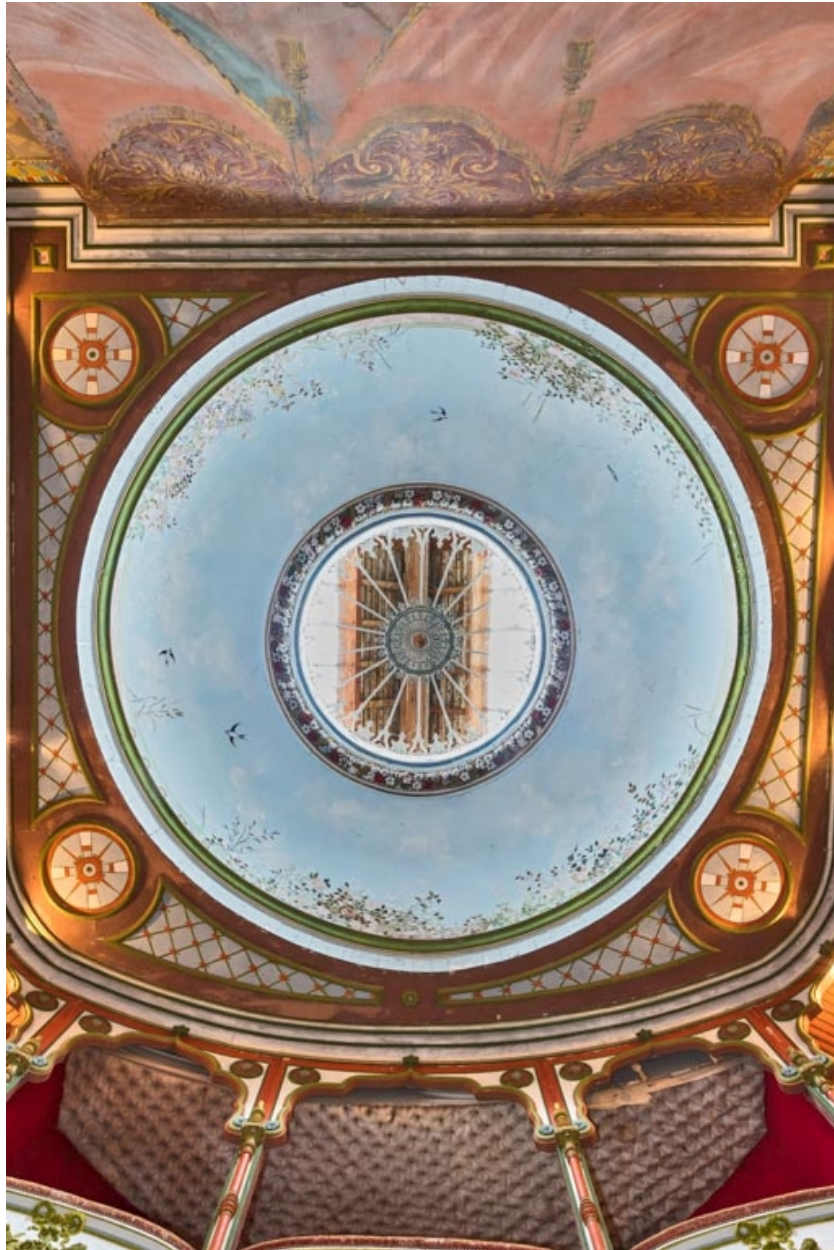
Salle : vue d'ensemble du plafond (fausse coupole).
