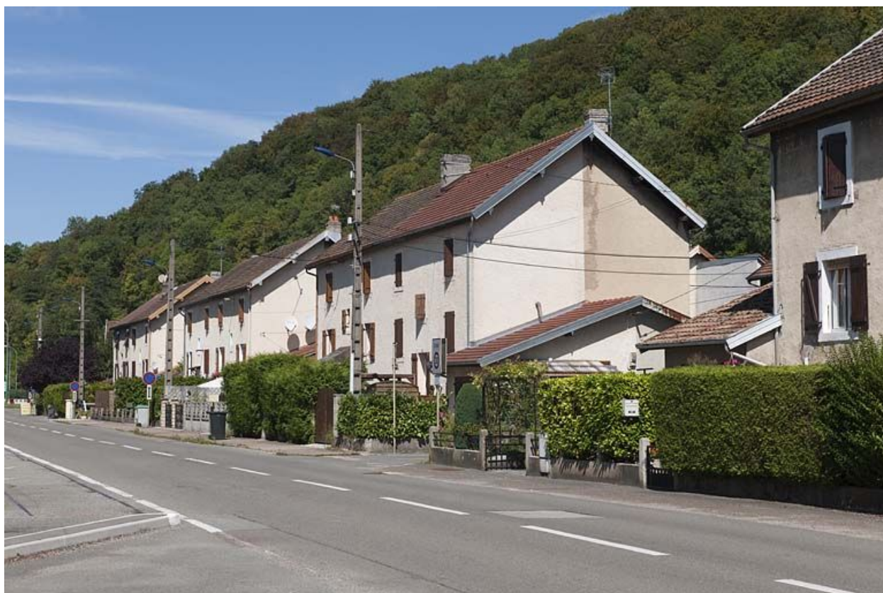
Maisons ouvrières rue des usines.
