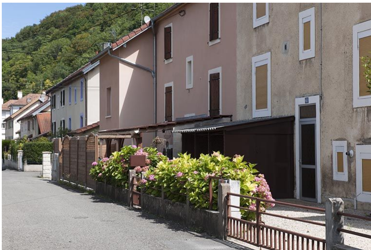
Façades ouest d'habitations ouvrières.
