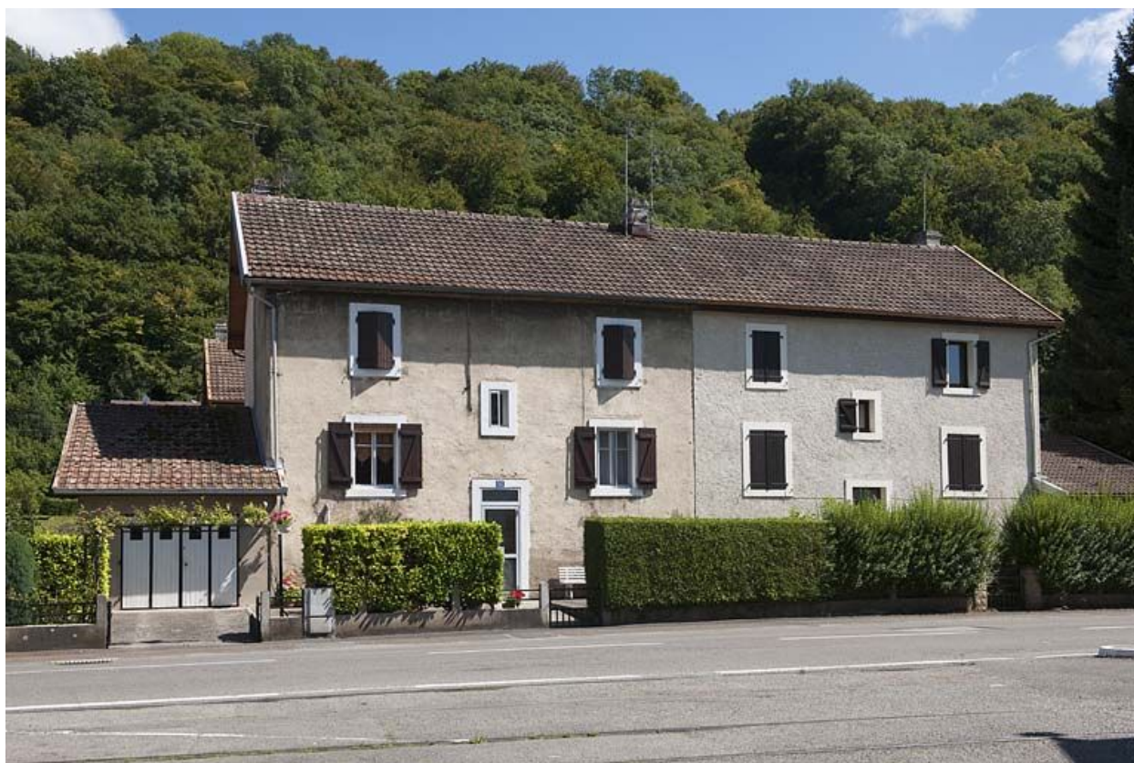
Façade ouest d'une habitation ouvrière.
