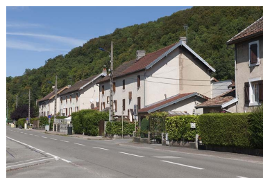
Maisons ouvrières rue des usines. Phot. Jérôme Mongreville IVR43_20112502280NUC4A
