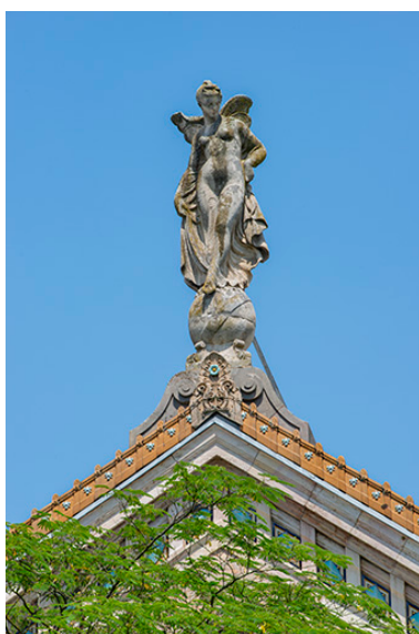
Vue de face. Phot. Jérôme Mongreville IVR43_20232500432NUC4A
