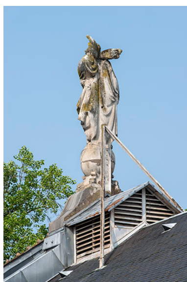
Vue de trois quarts, de dos. Phot. Jérôme Mongreville IVR43_20232500439NUC4A
