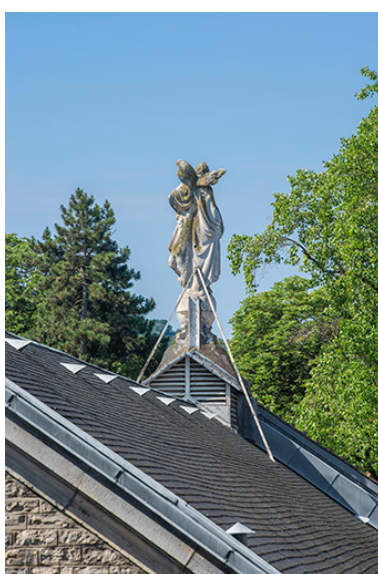
Vue de trois quarts, de dos. Phot. Jérôme Mongreville IVR43_20232500419NUC4A
